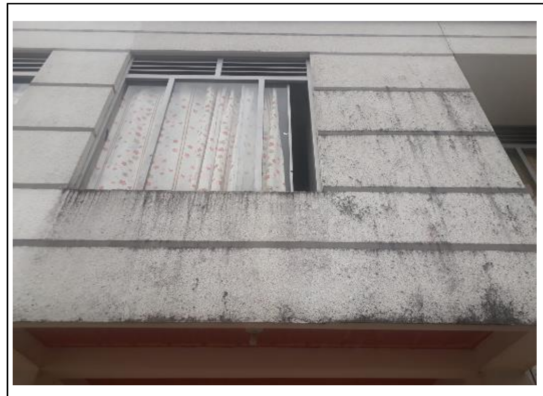
Fachada segundo nivel del inmueble.
