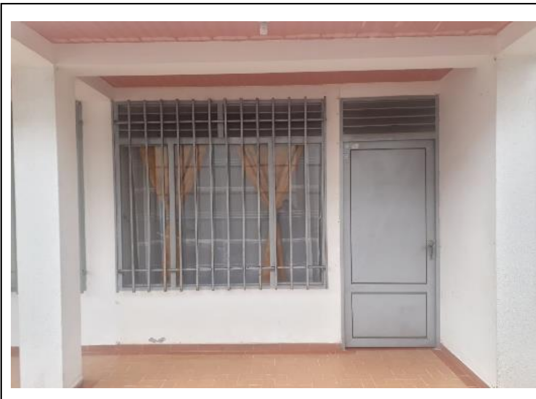
Fachada primer nivel del inmueble.
