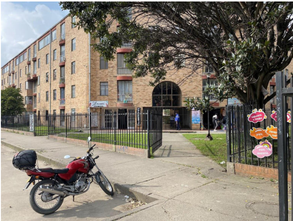
Fachada, área de ingreso al local 101, panorámica, vecindario al Sur
