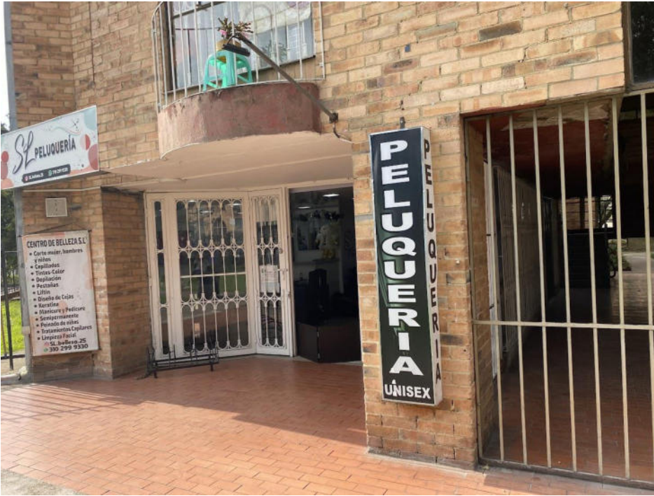
Calle 143A # 128-51 IN10 LC 101(peluqueria) Conjunto Residencial San Andrés Afidro
