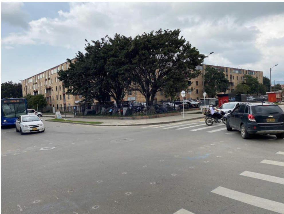
Panorámica frontal esquinera, del local 101 y su manzana 3 etapa 1 (obsérvese al fondo el local)
