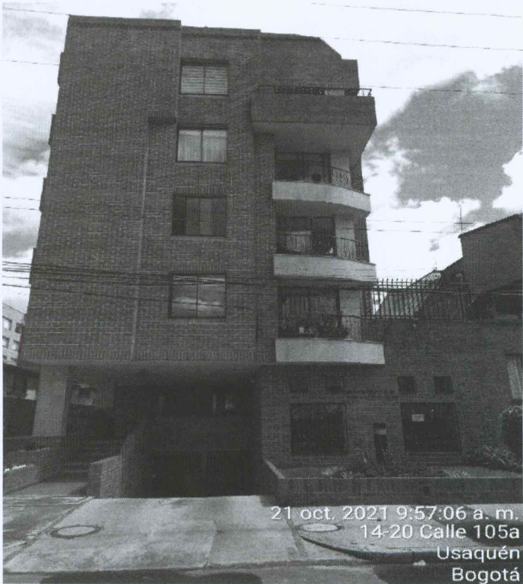
EDIFICIO MARGONVILLA III
