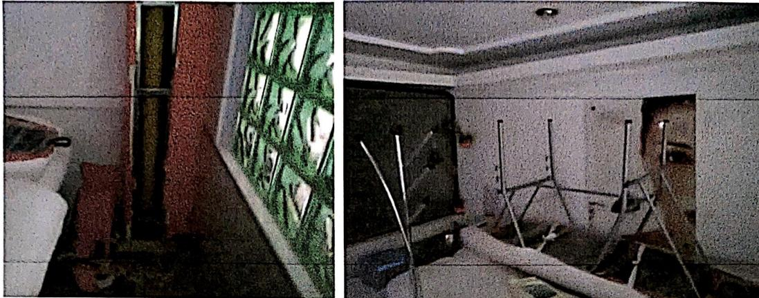
Dadas estas referencias, es para nosotros concluyente en forma técnica, que las afectaciones obedecen a las deficiencias que presenta el sistema de evacuación de aguas lluvias, derivadas de su falta de mantenimiento y verificación de su funcionamiento.
