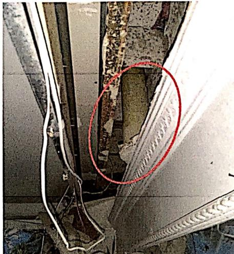
Es importante advertir que, como se puede identificar en esta última imagen, se evidenció la existencia de una tubería sin conexión y sin continuidad para identificar si hace parte de la red de bajantes y reventilación sanitaria o de aguas lluvias de su sistema de evacuación, que podría haber sido la causante de dicha afectación.
