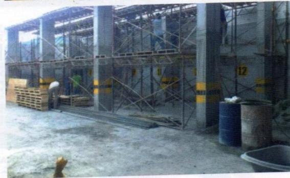
sistemas de las bases o de las zapatas, vigas de piso para posteriormente proyectasen las columnas correspondientes sobre todo el terreno, de acuerdo al proyecto y licencias aprobadas. Como se puede apreciar en el registro fotográfico anterior el sistema estructural por la parte perimetral del inmuebles como las internas o intermedias, son nuevas por lo cual el "Edificio Inteligente Metrópolis", está sobre un sistema estructural nuevo, con entre-placas y demás de obra nueva.
