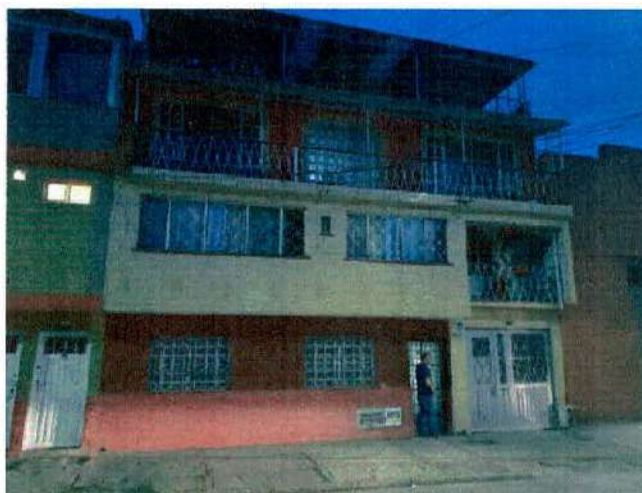
Vista de Fachada
