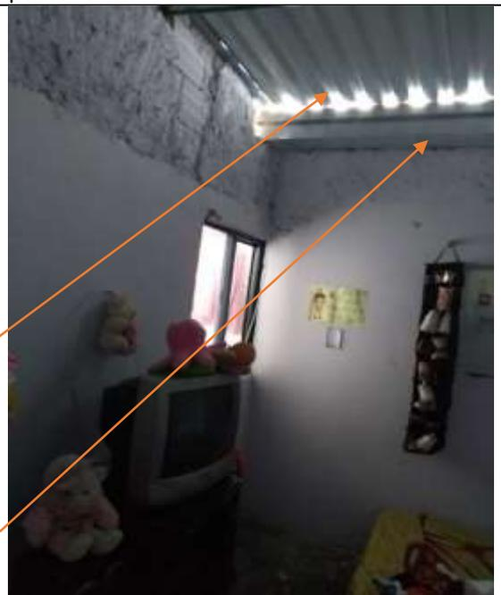
Vista interna de alcoba 2. Se observa cubierta ampliada en lámina ACEROLIT y canal de aguas lluvias.
