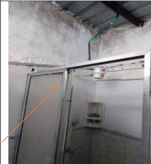
Vista interna del baño en donde se observa división metálica de la ducha en aluminio y acrílico corrugado.
