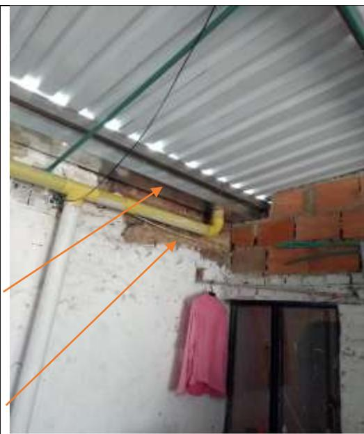
Vista interna desde el patio en donde se observa canal metálica y tubería de desagüe aguas lluvias que recoge la nueva cubierta.
