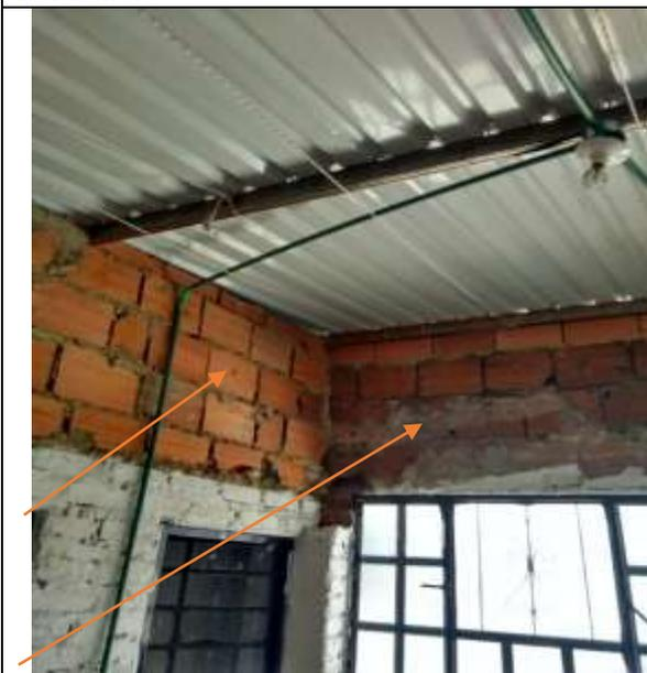
Vista interna desde el patio. Se observa muro cumbre en mampostería en bloque de arcilla N°5 que fue necesario para la pendiente de la de la construcción de la cubierta.
