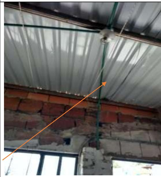
Vista interna del patio donde se observa tubería eléctrica CONDUIT en ½" (pulgada), para la instalación de la roseta punto eléctrico de iluminación.
