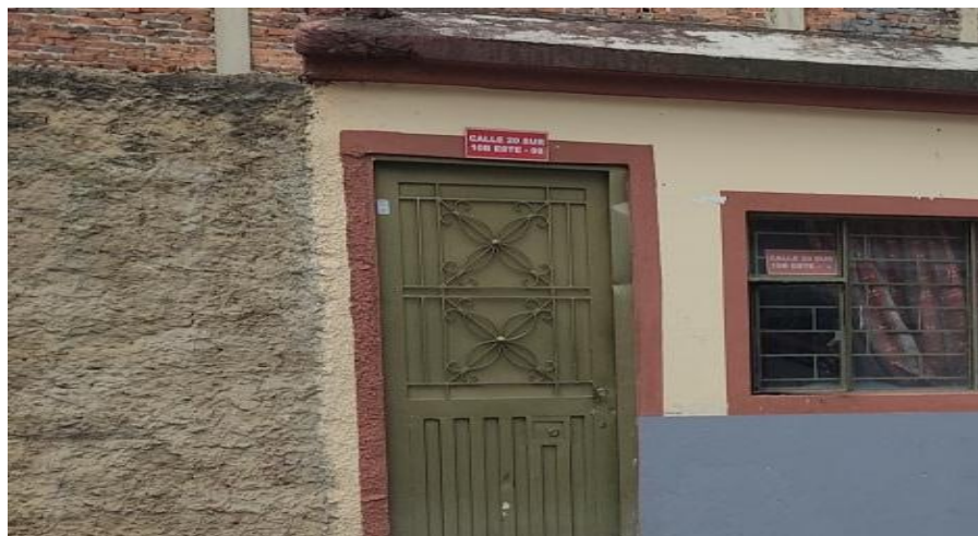
FACHADA POR LA CALLE 20 SOBRE LA PENDIENTE
