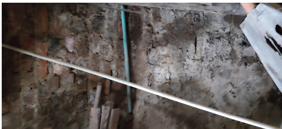
MURO DE CONTENCION
