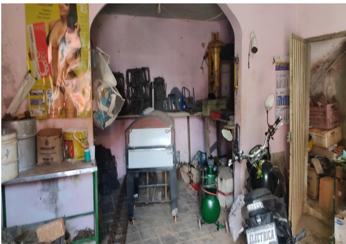
PISO EN BALDOSA DE CMENTO EN BODEGA, FLEJES DE HIERRO AL FONDO HORNO DE PAN
