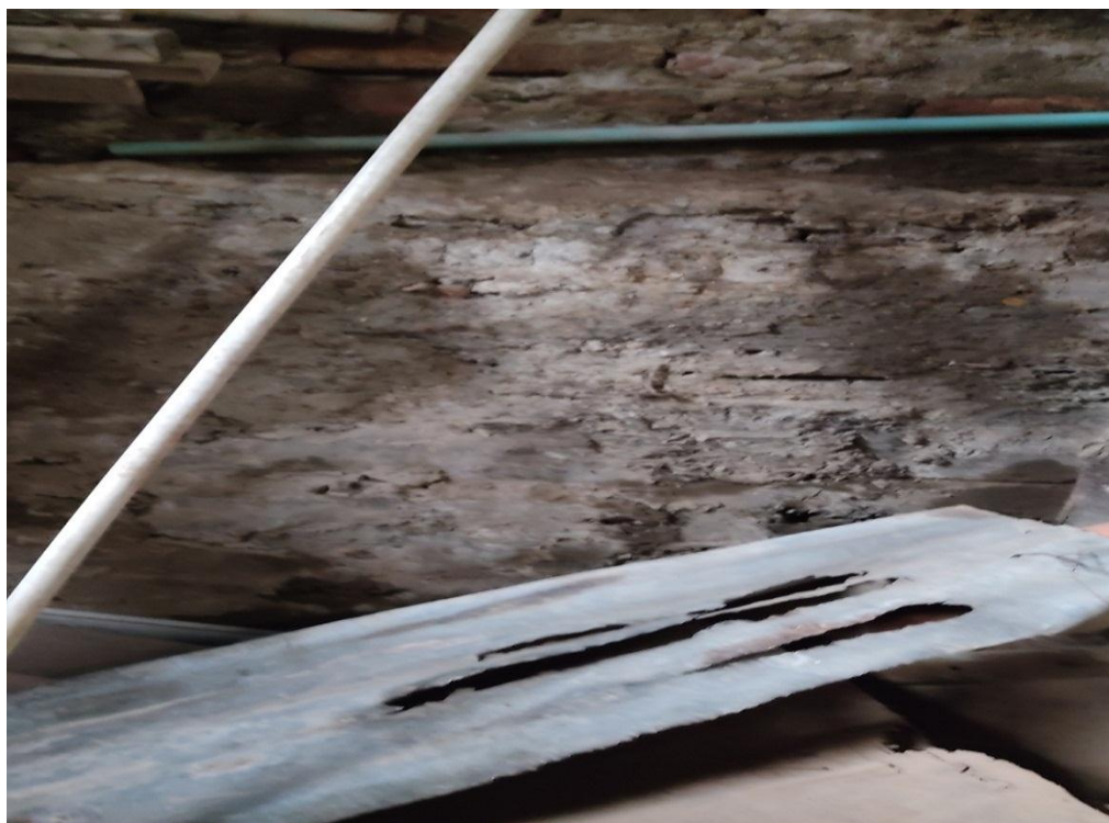
Muro de contención en la fachada del predio
