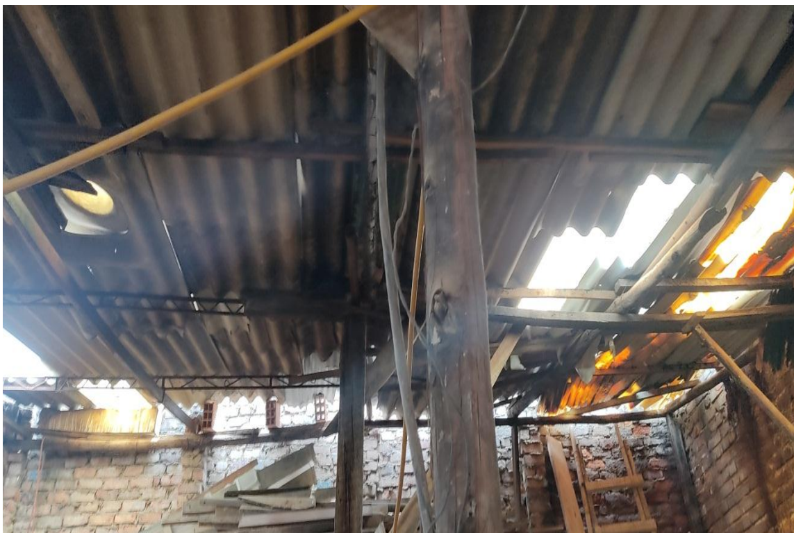
CUBIERTA DEL PREDIO EN ZINC,
