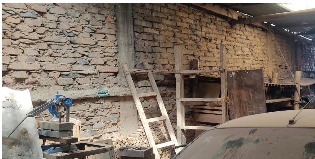
CUBIERTA DE GARAJE VISTA DE ORIENTE A OCCIDENTE
