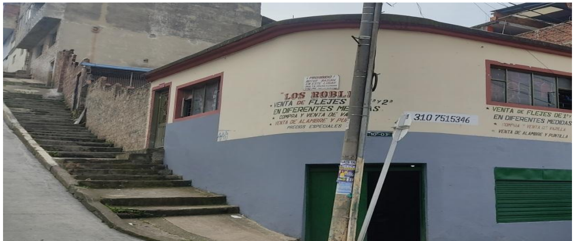
FACHADA DEL PREDIO DE LA CALLE 20 Sur No. 10B-03 ESQUINERO BARRIO MERCEDES LOCALIDAD 4 DE SAN CRISTOBAL
