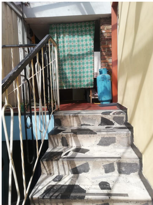
Escaleras acceso al cuarto piso – de frente la cocina
