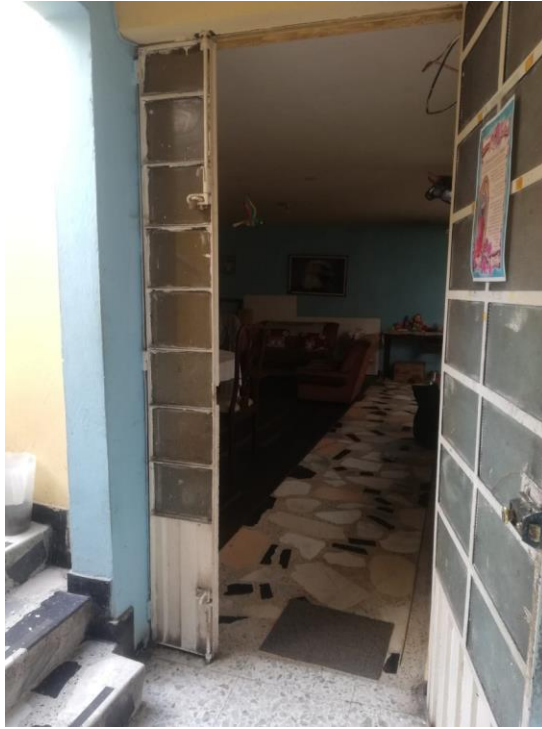
Acceso al apartamento que se encuentra en el primer piso
