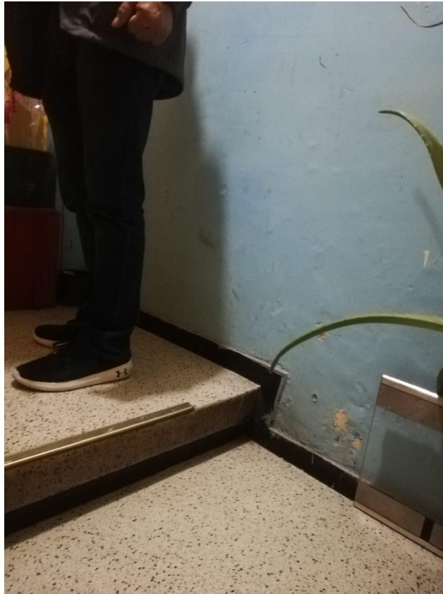
Escaleras que conducen al segundo piso
