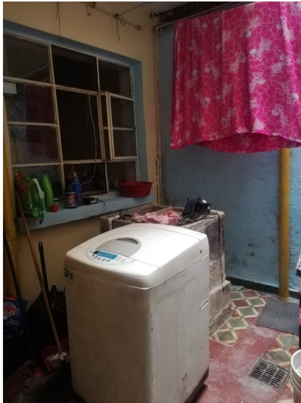
Patio del apartamento del primer piso
