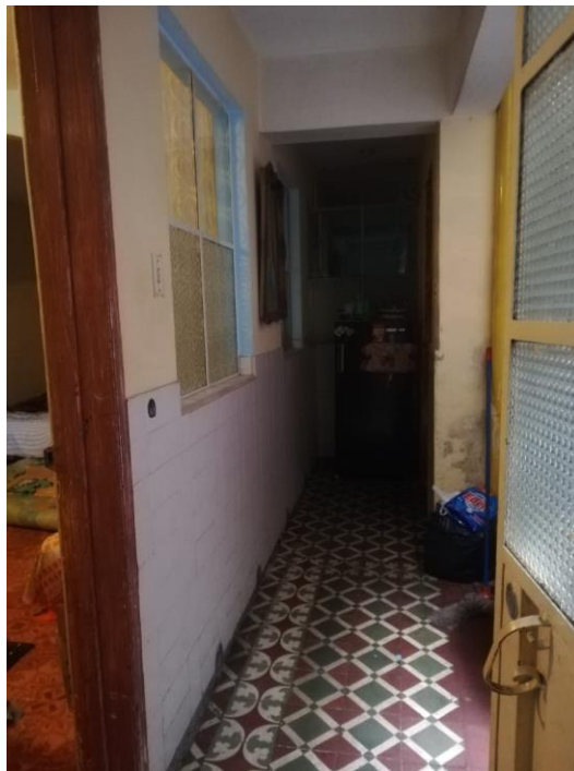
Hall del apartamento del primer piso
