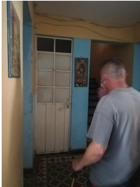
Primer piso hall – baño de la habitacion que da hacia la fachada
