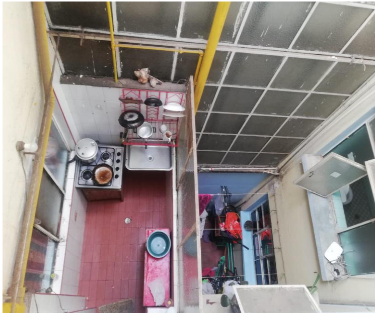
Cocina segundo piso – vista desde el tercer piso con un vacío hacia el primer nivel para iluminar y ventilar
