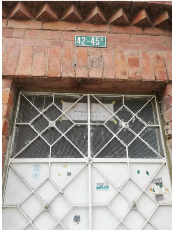
Nomenclatura de la puerta principal del predio
