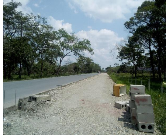
Vías de acceso
