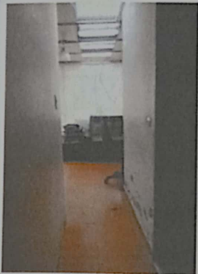
Pasillo de circulación
