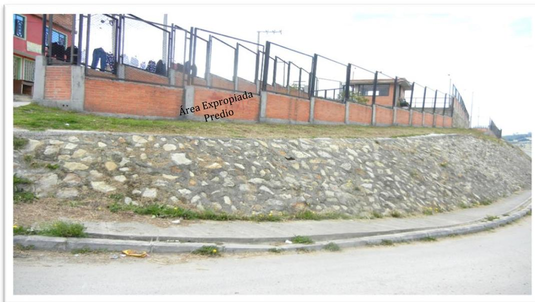
*La foto No.5, muestra la construcción de las instalaciones donde funcionan las oficinas y tanque del acueducto, así mismo el enrocado al talud para su estabilización*
