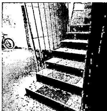
ESCALERAS A PISO-2
