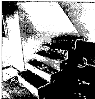
ESCALERAS A TERRAZA (CUBIERTA)
