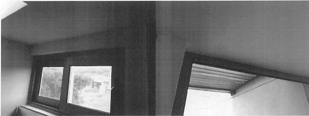
Los cielo rasos presentan falencias en calidad en cuanto a alineación, nivelación y terminación del acabado, por lo que se debe realizar un remate general de toda el área del cielo falso, e incluir el arreglo y/o corrección de las fisuras que se observan en gran parte de la vivienda.
