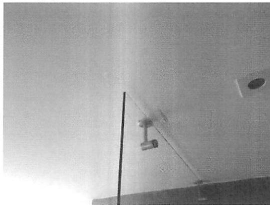
En cuanto a las divisiones de vidrio de los baños se observa que en los sitios a techo donde están soportadas estas, el material comienza a evidenciar descascaramientos, por lo que se debe revisar el tipo de lámina de los cielos instalados en estos puntos y verificar si son láminas de especificación HR, debido que esto puede conllevar a la caída de la división.
