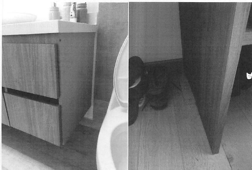
La carpintería de madera se observa en su totalidad falta de detalles, con piezas faltantes de su revestimiento final, los parales de closets soportados por pedazos de madera mal instalados y de pésimo acabado, adicional existen puntos en donde se realizó mal la instalación, dejando huecos y rayones a la vista.
