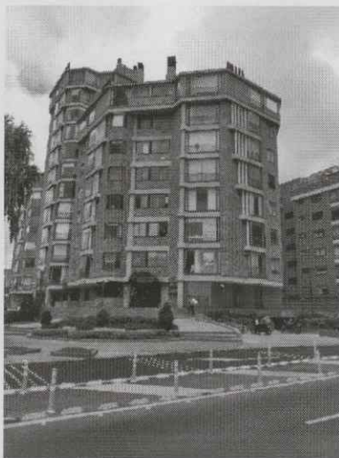
FACHADA DEL EDIFICIO PLAZUELA DE SAN JORGE
