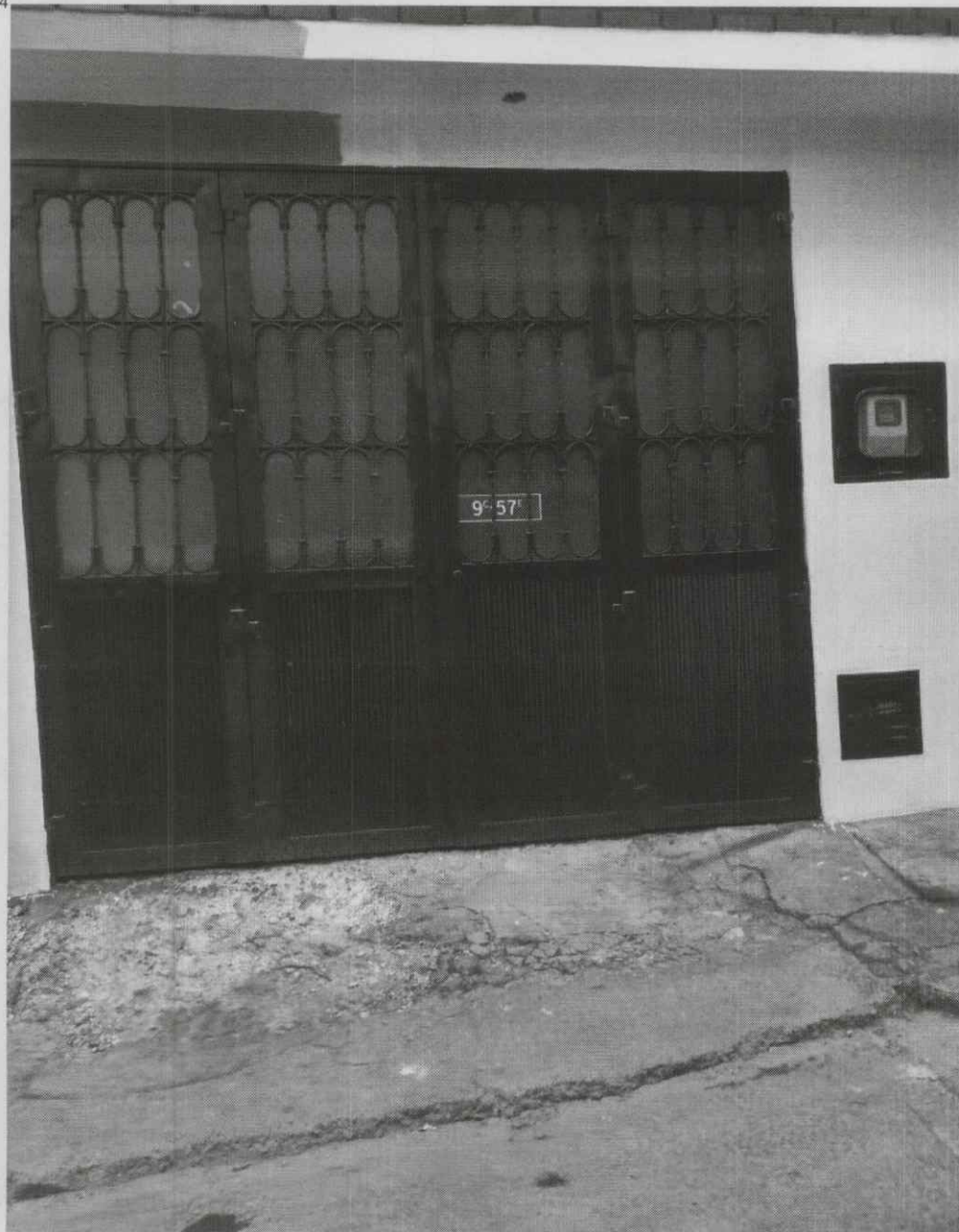
Fotografía No. 1 - Fachada
