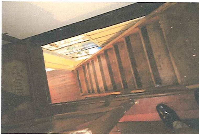
Escalera Acceso Habitación Adecuada Sobre Habitación Del Fonda
