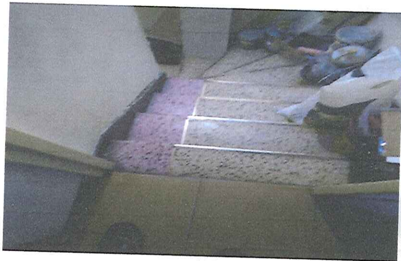
ESCALERA ACCESO 2DO NIVEL
