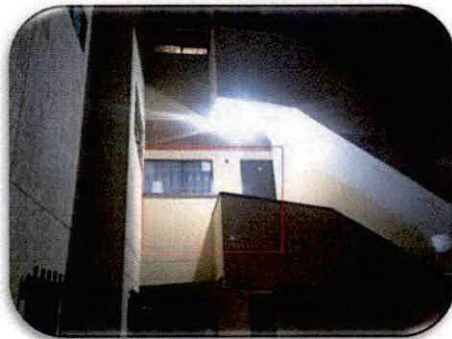
FACHADA AP 202 TA
