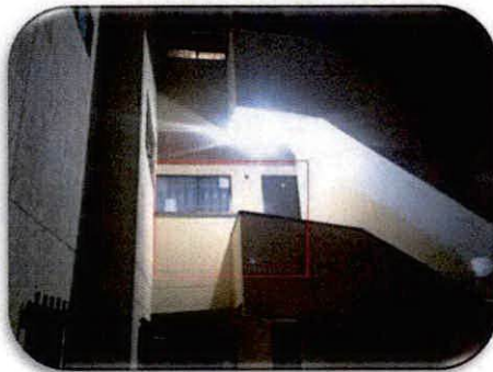
FACHADA AP 202 TA
