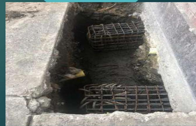
6. Conexión de viga - pilote
