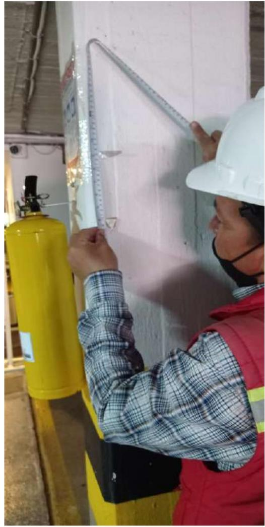
A estos puntos se les realizo contra nivelación entre los mismos cambios, verificando las diferencias de altura entre los mismos, y asegurando su precisión con una tolerancia máxima de 1mm entre armadas.
