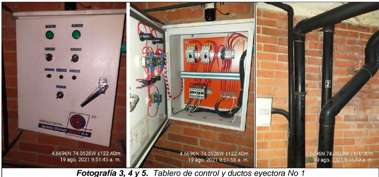
**Pozo 2.** Consta de un pozo ubicado en el parqueadero A-501A y un equipo eyector de dos bombas Ignacio Gómez IHM S. A, con operación automática y manual; dispone de un tablero de control, una alarma y dos ductos que conducen las aguas a la cámara de inspección de aguas residuales ubicado en el primer piso y de este, por gravedad se descargan a la red del alcantarillado (carrera 12) de la EAAB. Fotografías 7, 8, 9 y 10.
