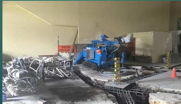
5. Inyección de concreto fluido
