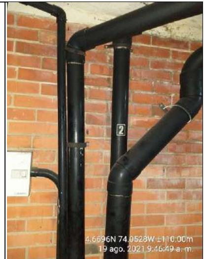
**Fotografía 8, 9 y 10. Tablero de control y ductos eyectora No 2**
