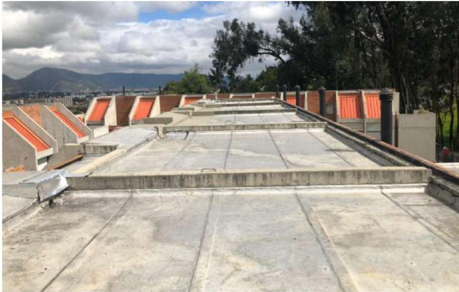
De acuerdo a las post ventas realizadas en cubierta para el tratamiento de fisuras, se aplicó el producto poliuretano Vulkem el cual se ha implementado en todas las actividades a realizar fisuras; En respuesta anterior se hace mención del producto y sus especificaciones.
