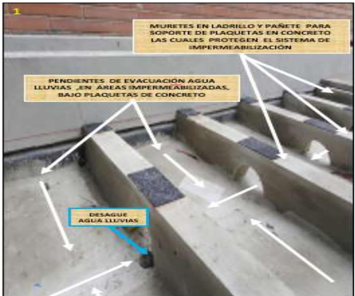
Los desagües en placa central peatonal no necesitan ningún elemento tipo rejilla ya que al ser un elemento lateral no aplica
