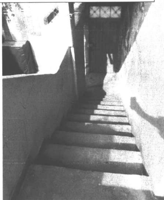
ESCALERA ACCESO 2DO PISO
