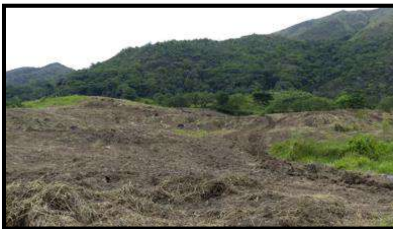
Fotografía 93 Preparación terreno sector I
