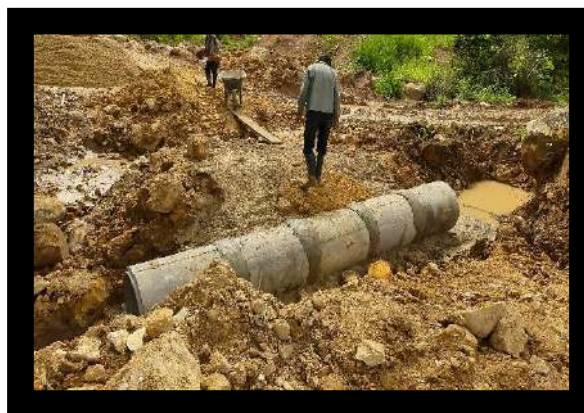
Fotografías 1 y 2: Construcción de paso cañada No. 2.
