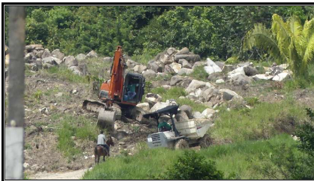
Fotografía 4442 Extracción de piedra sector I.
