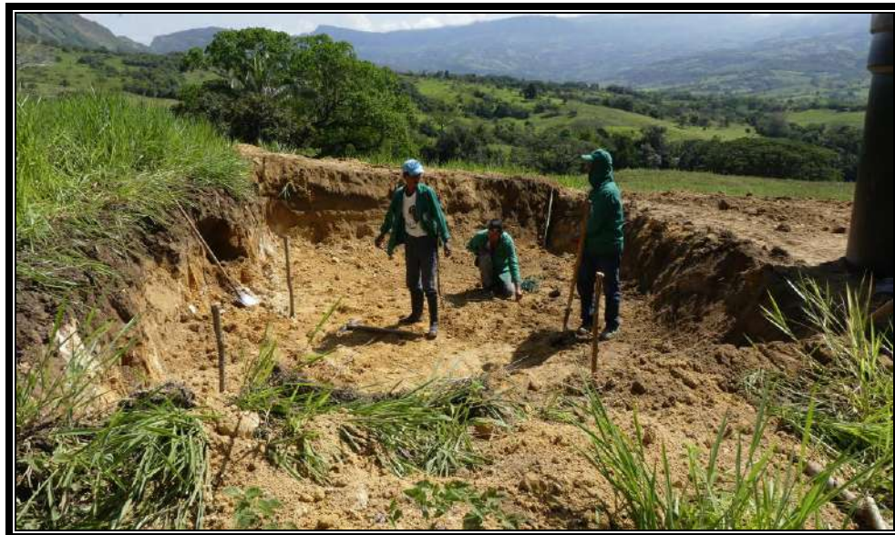
Fotografía 1715 Nivelación terreno para ubicación de tanques de almacenamiento de agua, sector H.
