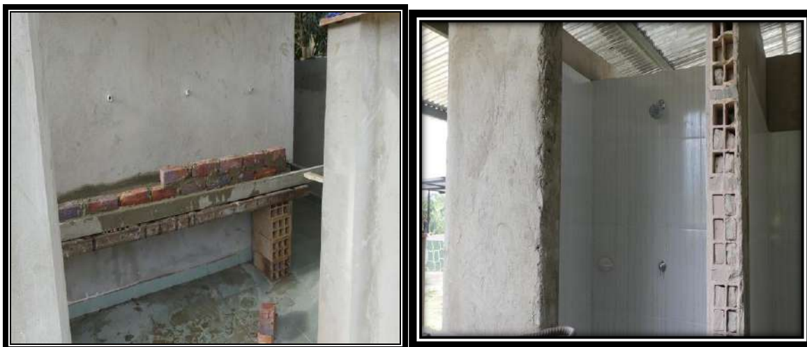
Fotografía 1413 Enchape batería de baños.
