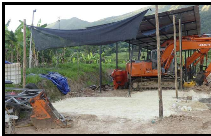
Fotografía 1514 Nivelación de terreno para construcción de taller.
