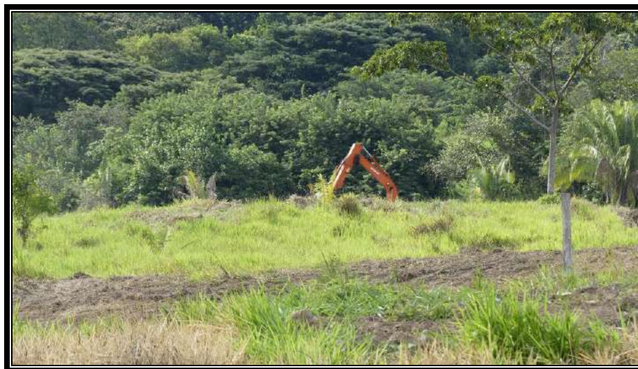
Fotografía 2220 Extracción de piedra Sector I.
