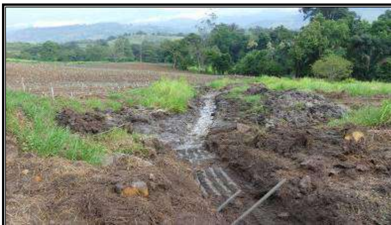
Fotografía 14. Canal de drenaje escorrentía Sector A.
