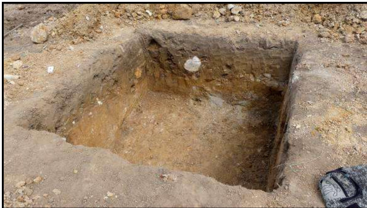
Fotografía 87 Excavación para construcción de PTAR
