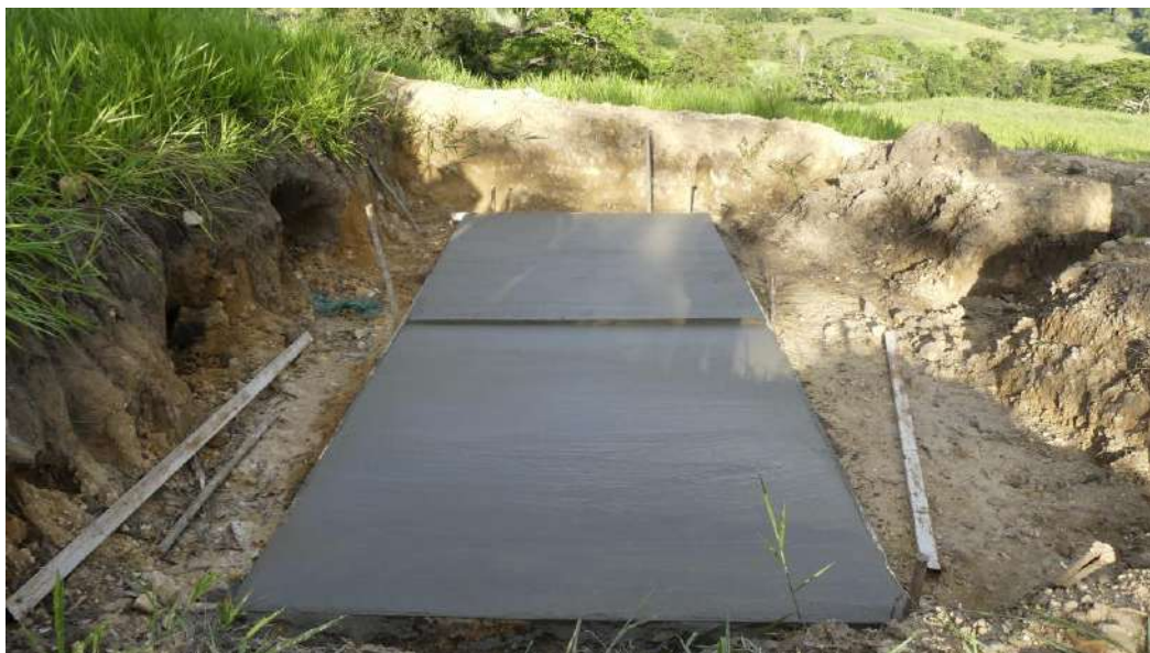
Fotografía 4139 Piso para ubicación de tanque para almacenamiento de agua sector G.
