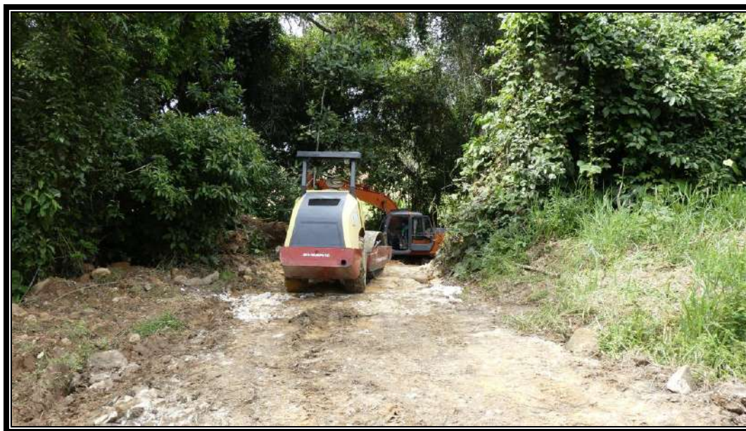
Fotografía 4845 Apertura vía alterna para paso vehicular.
