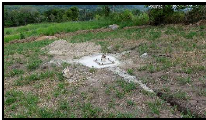
Fotografía 66: Fundición base pararrayos.
