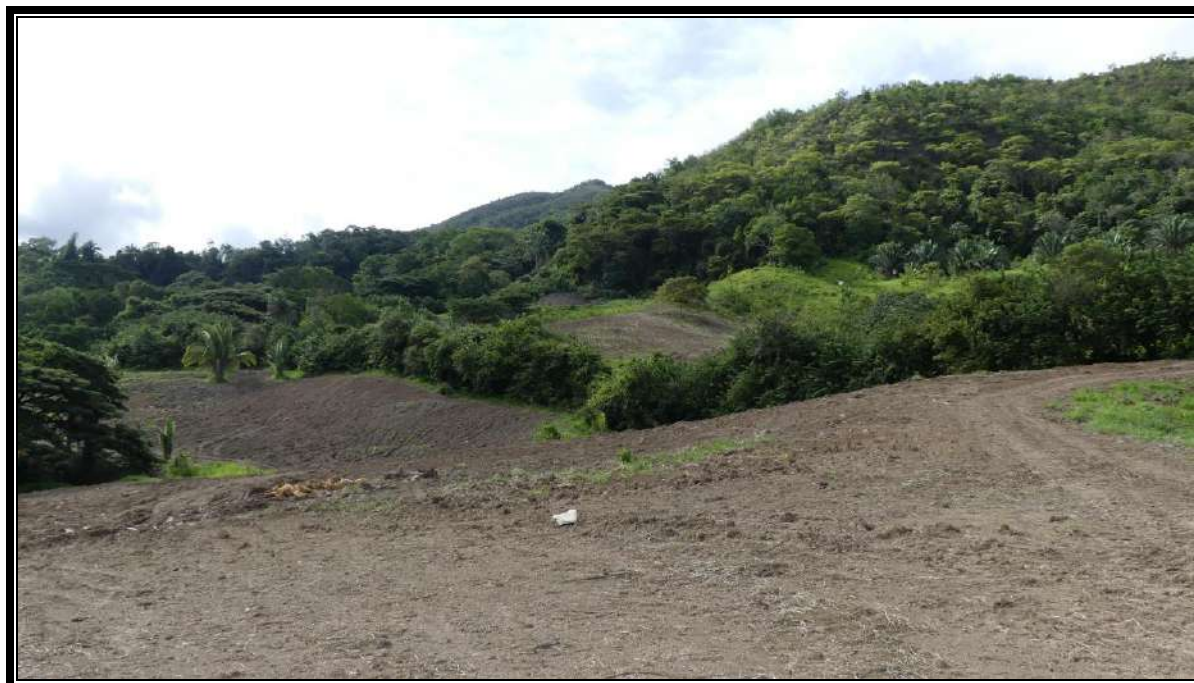
Fotografía 3129 Preparación de terreno sector I / J.
