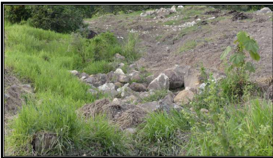
Fotografía 4946 Acopio de piedra sector F.
