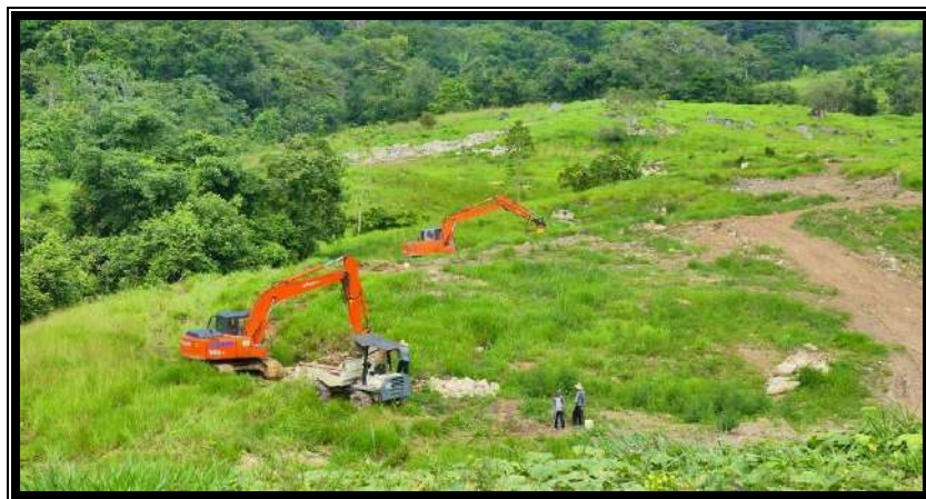
Fotografía 21: Trituración y extracción de piedra Sector F
