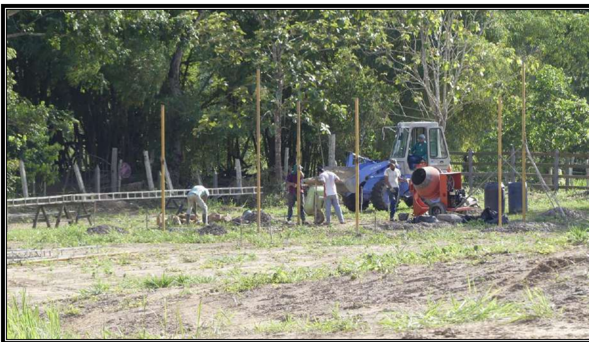
Fotografía 3836 Cimentación casa Finca Cunday 1.
