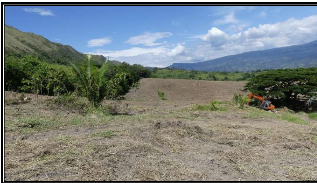
Fotografía 808 Alistamiento de terreno sector I Extracción de piedra.
