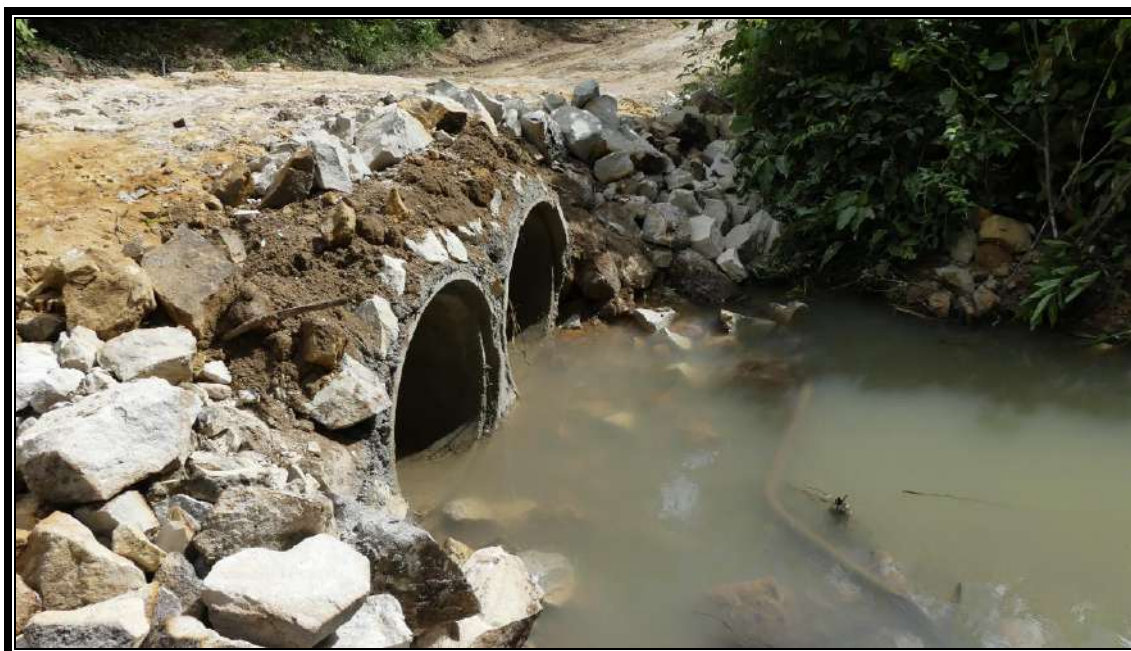
Fotografía 4644 Adecuación de tubería para ubicación de tubería para puente tipo badén.
