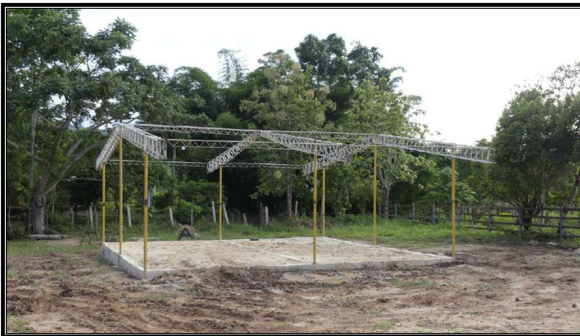
Fotografía 4341 Montaje de estructura vivienda finca Cunday 1.
