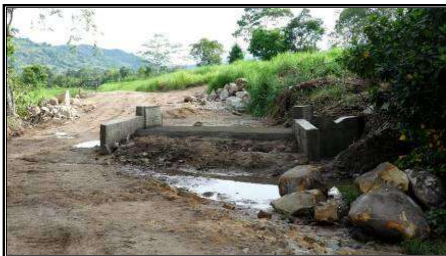
Fotografía 29: Puente tipo badén sector primera quebrada.
