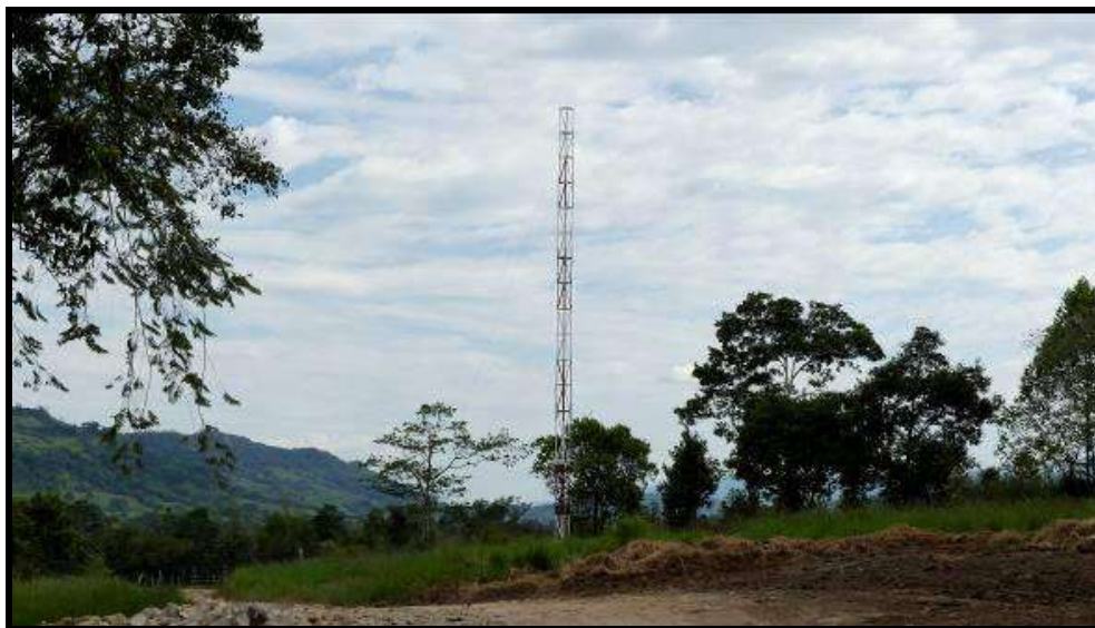
Fotografía 84 Instalación pararrayos sector Corrales
