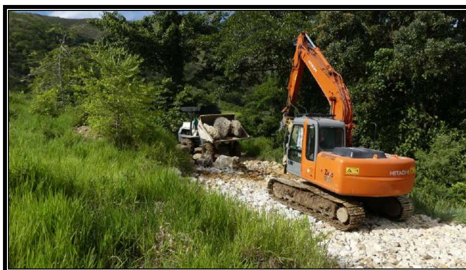
Fotografía 2119 Mantenimiento vía mirador.
