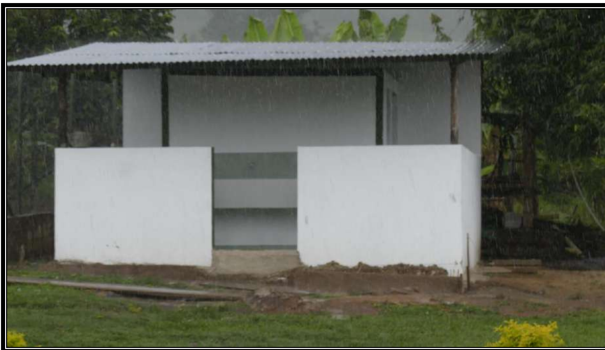
Fotografía 4038 Acabados de batería sanitaria.
