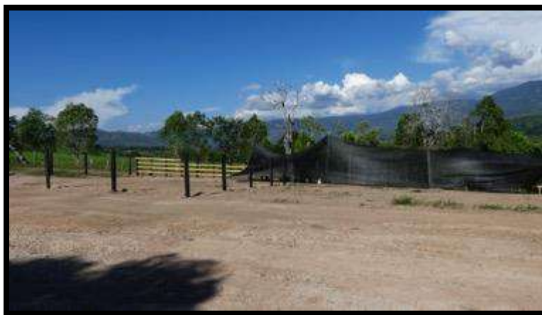
Fotografía 92 Nivelación de terreno
