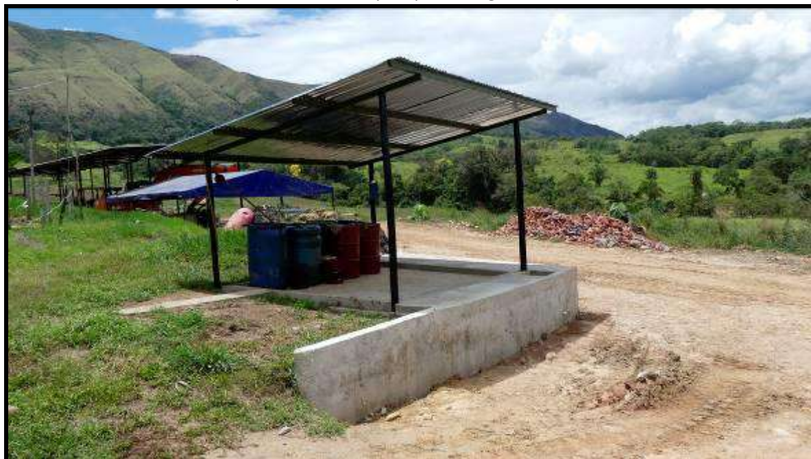
Fotografía 86 Área de almacenamiento de combustibles
