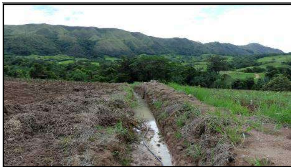
Fotografía 43: Zanjas perimetrales para manejo de aguas Sector G y C
