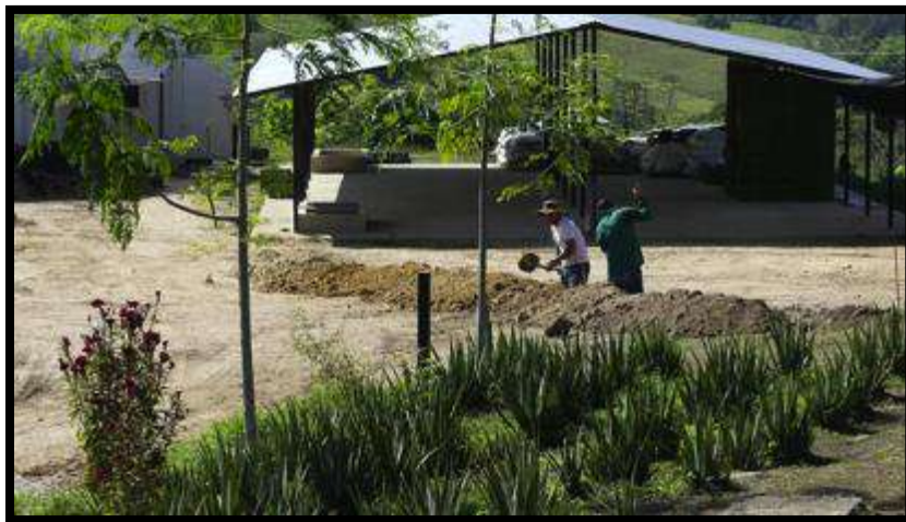
Fotografía 100 Instalación de tubería
