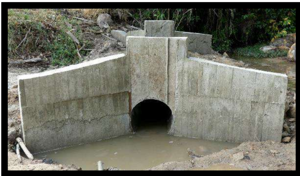
Fotografía 41: Construcción finalizada de puente tipo badén.
