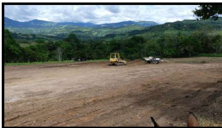
Fotografía 60: Nivelación de terreno, sector Animales.
