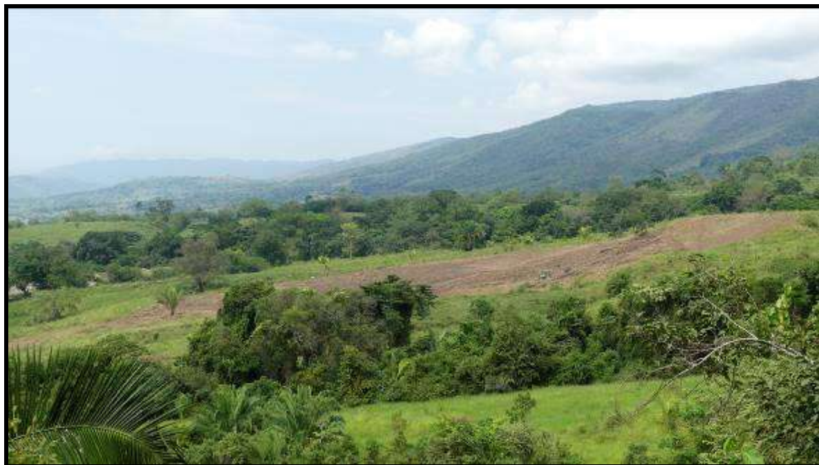
Fotografía 83 Actividades de preparación del terreno sector I
