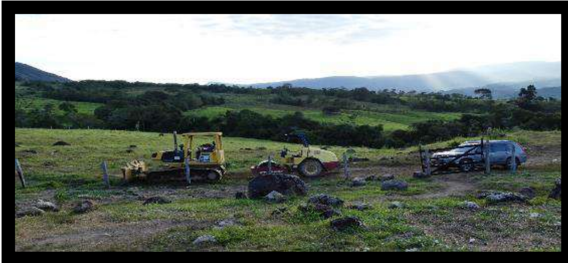
Fotografía 2: Llegada de maquinaria para trazado de vías.
