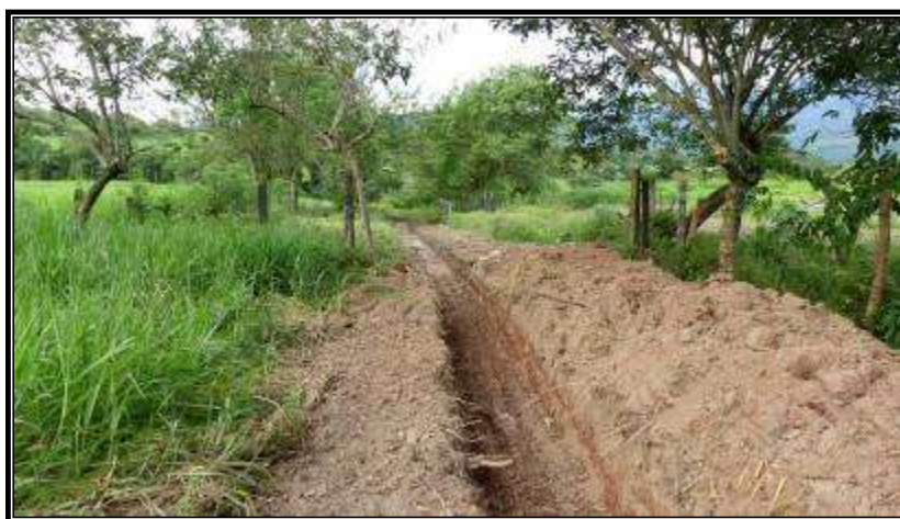
Fotografía 30: Zanjas para manejo de agua sector parte alta de F
