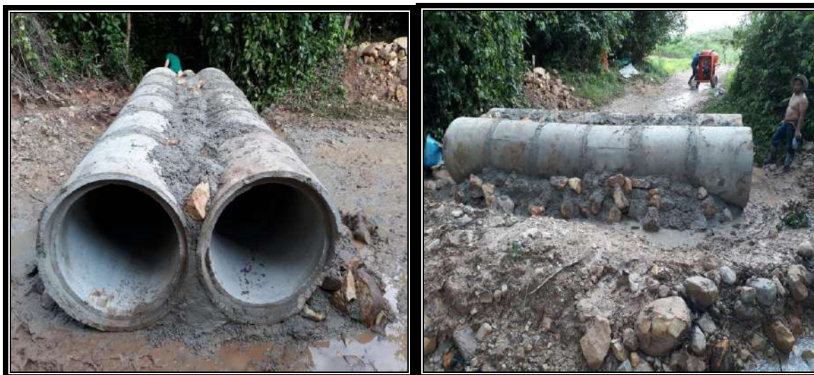
Fotografía 5452 Tubería Puente Baden.
