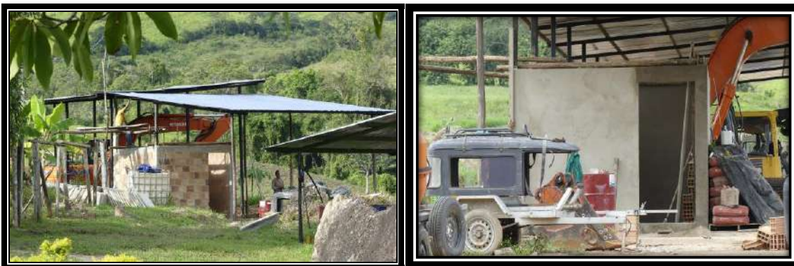
Fotografía 3937 Construcción de taller de maquinaria.
