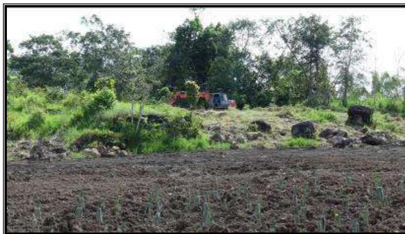
Fotografía 42: Extracción de Piedra Sector G. Retroexcavadora
