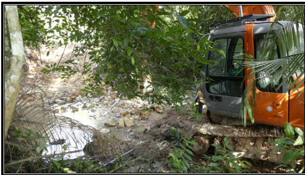
Fotografía 4745 Trazado de vía alterna para paso vehicular.
