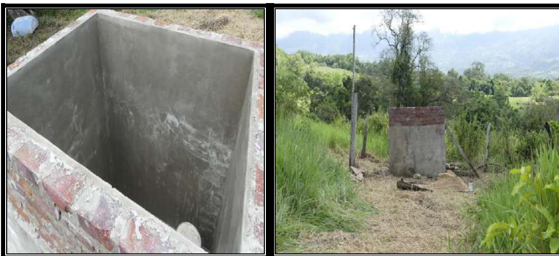
Fotografía 3735 Modificación tanque para almacenamiento de agua Sector E.
