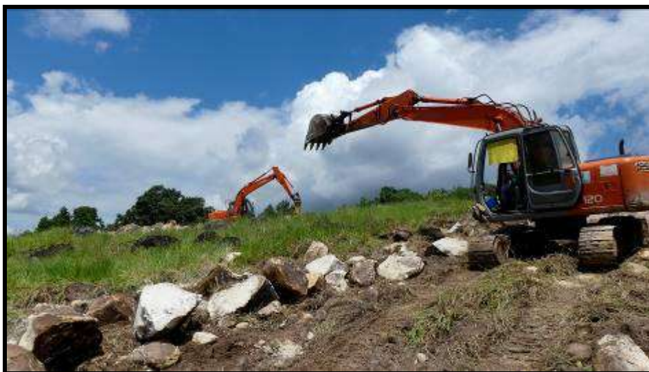
Fotografía 75 Extracción y trituración de roca
