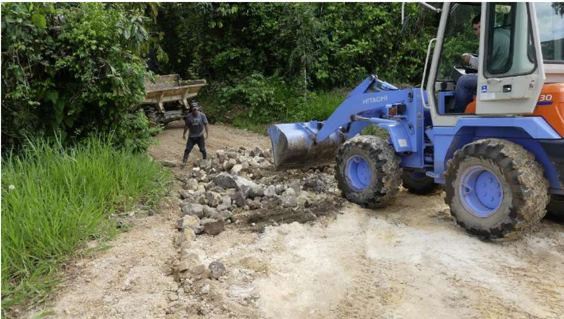
Construction of access roads Construcción de vías de acceso
