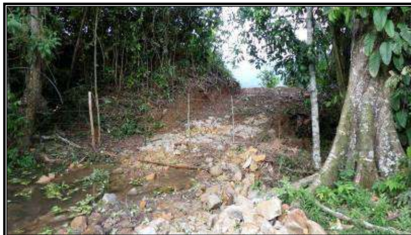
Fotografía 32: Apertura de vía sector tanque de almacenamiento de agua.
