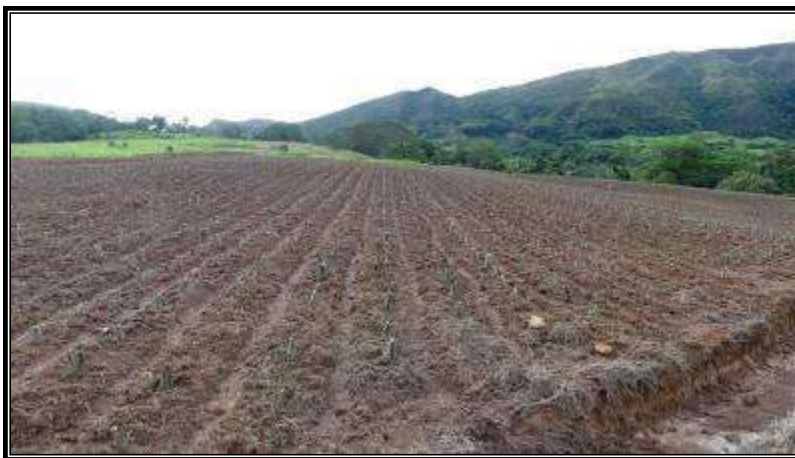
Fotografía 34: Sector C terminado.
