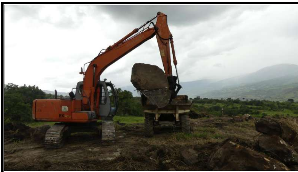
Fotografía 504 Extracción de Piedra sector H.
