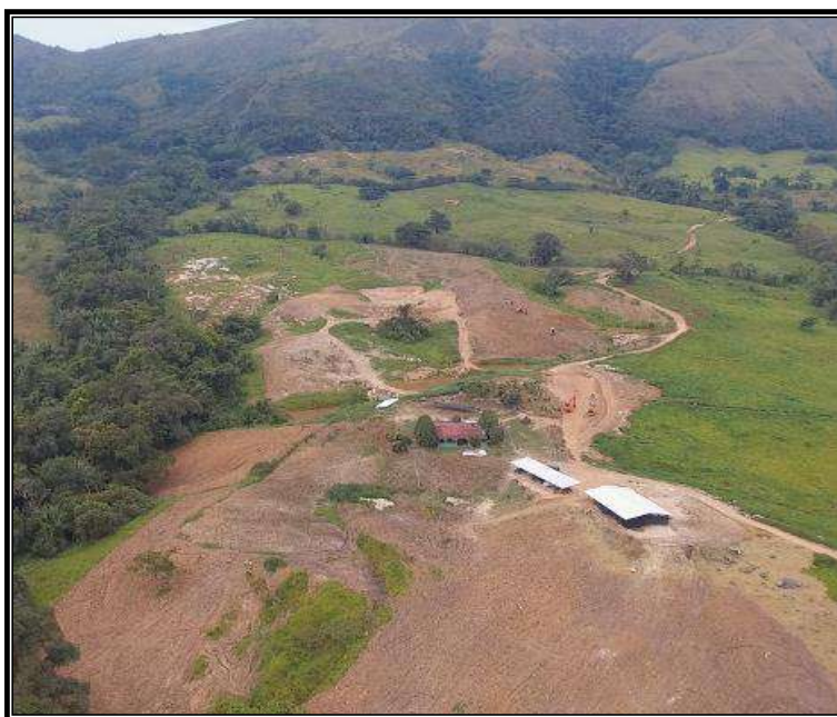
Fotografía 7. Vista Aérea avance sector F y A, y construcciones de parqueadero e invernadero.
