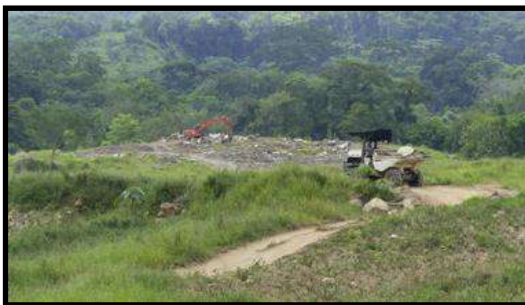
Fotografía 90 Extracción de roca
