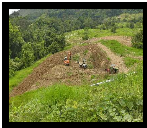
Fotografía 3 y 4: Extracción de piedra y arado subsolador sector F.
