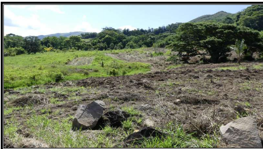
Fotografía 201 Extracción de piedra sector I
