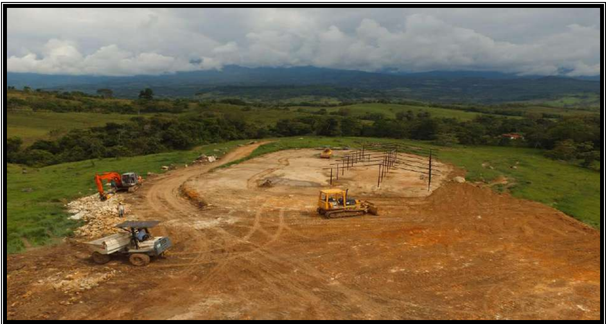
Fotografía 23: Instalación de perfiles para tejado del invernadero.
