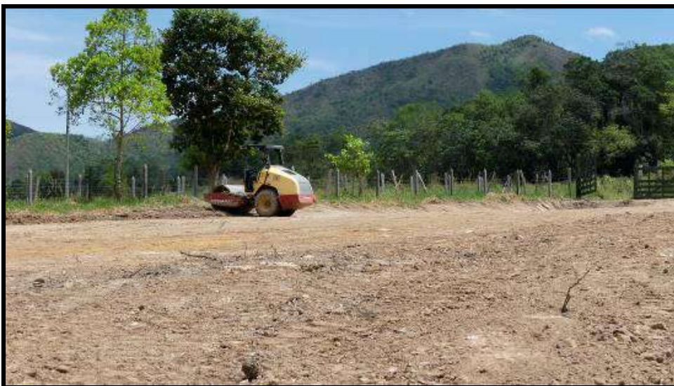
Fotografía 76 Compactación terreno corrales
