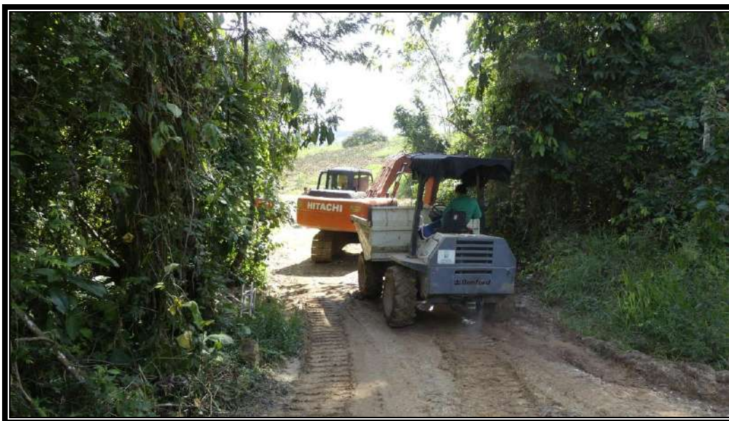
Fotografía 4543 Adecuación de terreno para ubicación de tubería para puente tipo badén.
