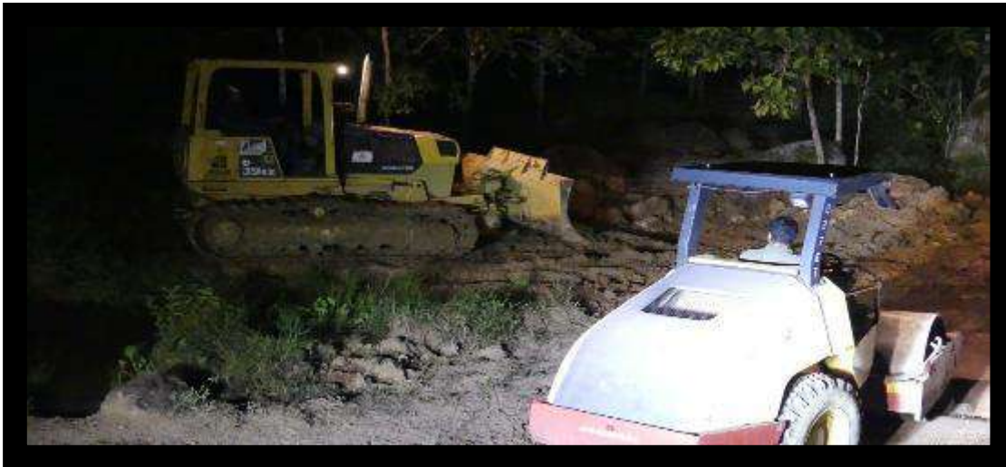
Fotografía 1: Llegada y apertura de vías de acceso.
