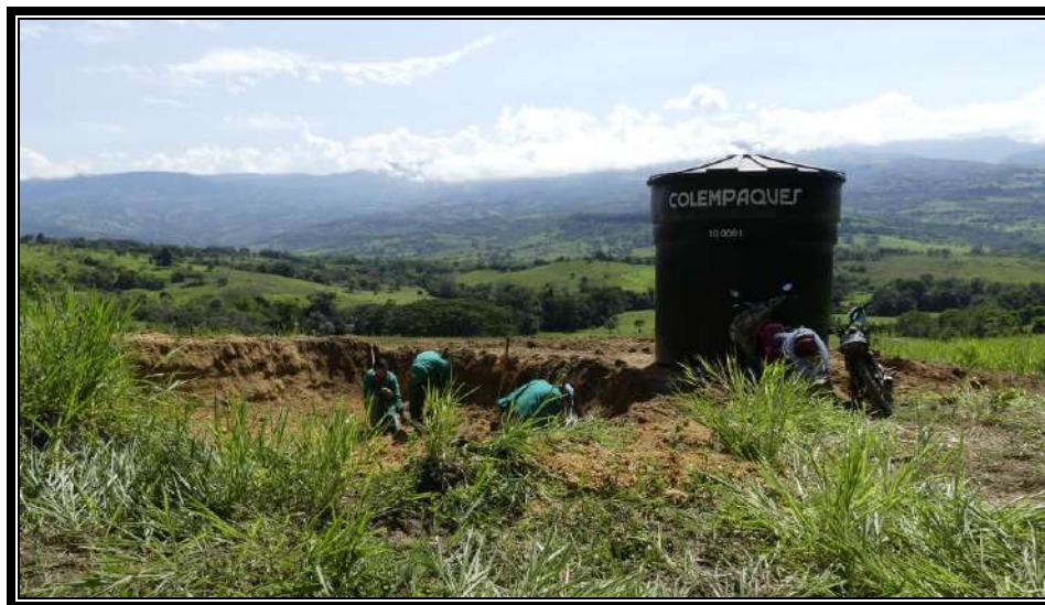
Fotografía 1816 . Nivelación terreno para ubicación de tanques de almacenamiento de agua, sector H.
