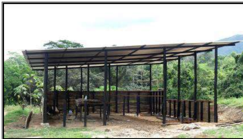
Fotografía 55: Estructura y techado de comedor.
