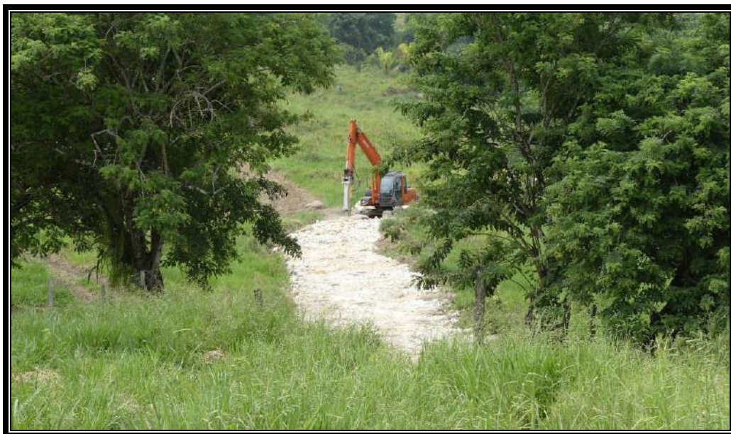
Fotografía 302 Mantenimiento de las vías principales de la finca Vía mirador
