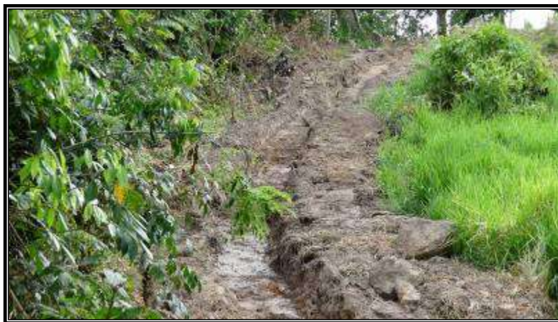
Fotografía 31: Zanjas de manejo de aguas.
