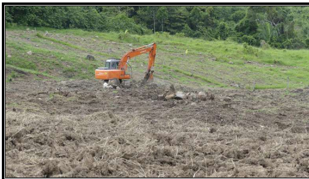
Fotografía 605 Extracción de piedra sector I
