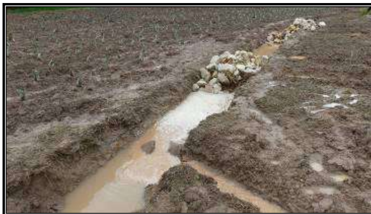
Fotografía 15. Canal de drenaje principal Sector B
