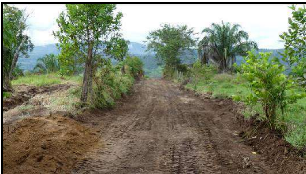
Fotografía 69 construcción vía sector H
