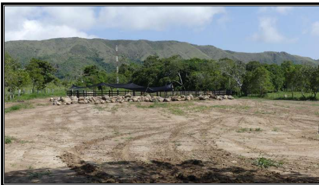
Fotografía 403 Nivelación de terreno para la construcción de área de oficinas y vivienda.
