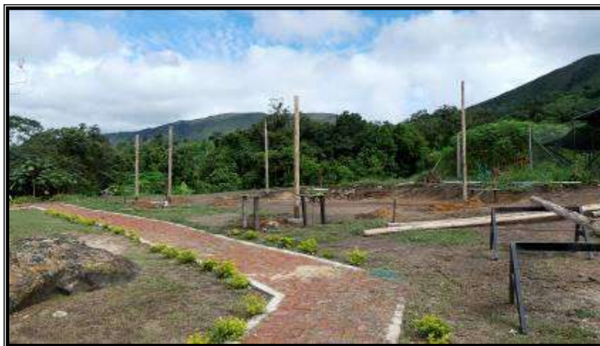
Fotografía 53: Instalación de Limatones para comedor.
