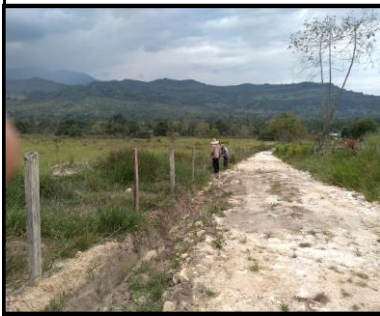
Road Construction / Construcción de vías
