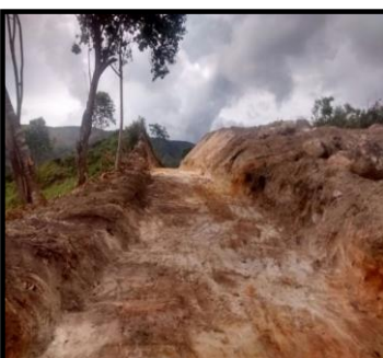
Road Construction / Construcción de vías
