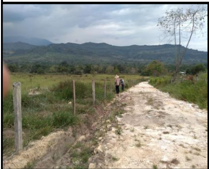
Road Construction / Construcción de vías
