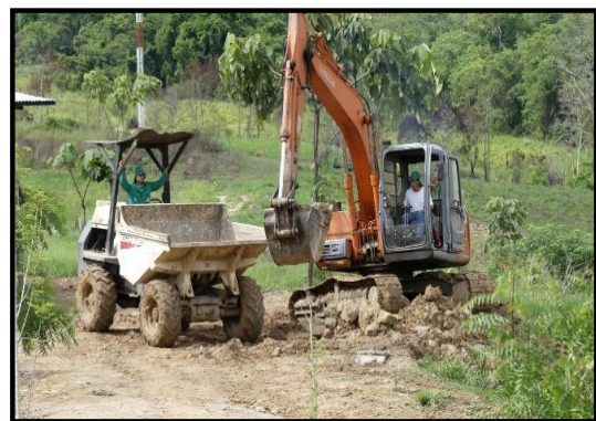
Road Maintenance / Mantenimiento de vías
