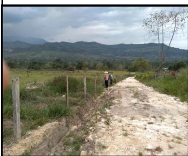
Road Construction / Construcción de vías
