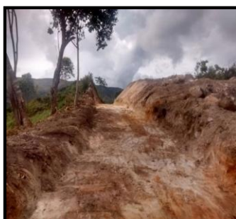
Road Construction / Construcción de vías
