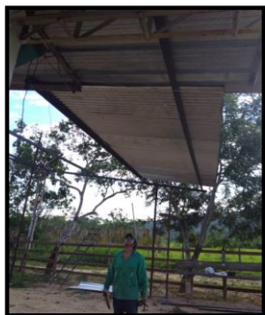
Mantenimiento de infraestructura
