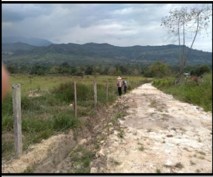
Road Construction / Construcción de vías
