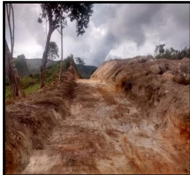
Road Construction / Construcción de vías
