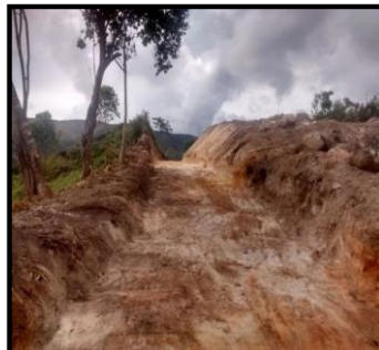
Road Construction / Construcción de vías
