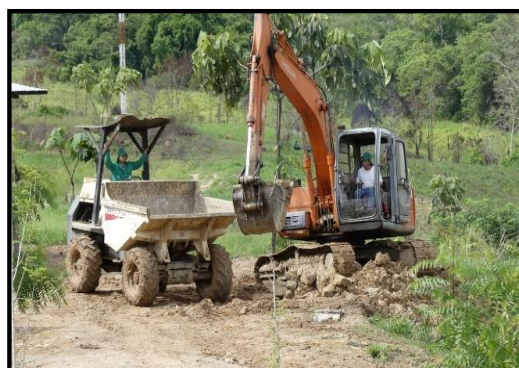
Road Maintenance / Mantenimiento de vías
