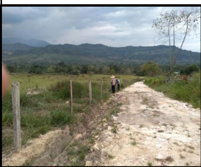
Road Construction / Construcción de vías
