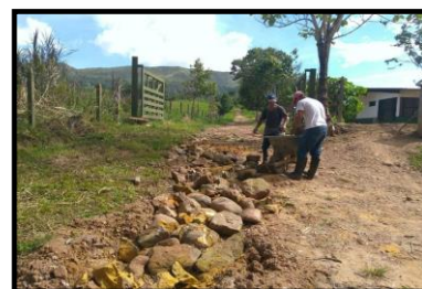
Mantenimiento de vías
