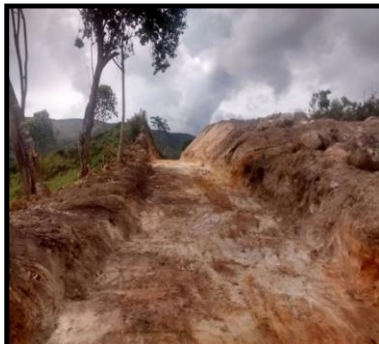
Road Construction / Construcción de vías
