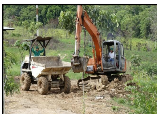
Road Maintenance / Mantenimiento de vías
