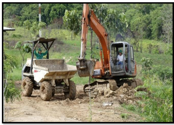
Road Maintenance / Mantenimiento de vías
