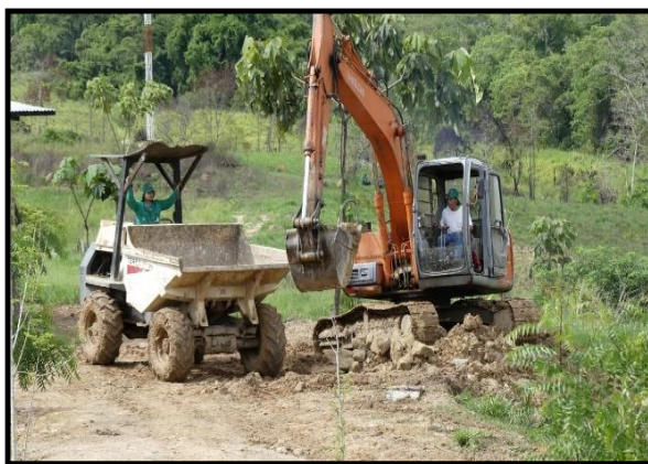
Road Maintenance / Mantenimiento de vías
