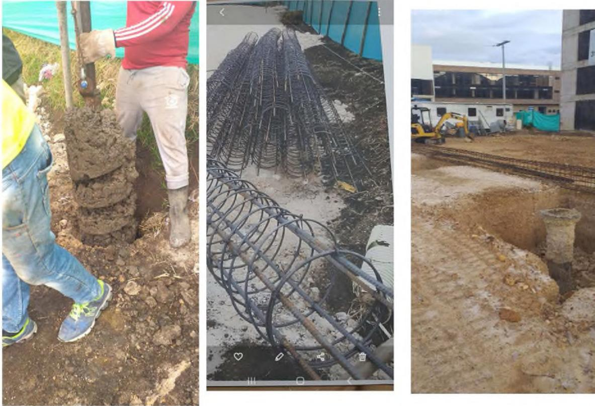
En las fotos se evidencia el diámetro del pilote el cual se construyo de 0.40m de diámetro, con una longitud de 12m. y no como se menciona en el informe de interventoria, que es dice que es de 25cm y 8m de longitud. Además se aprecia que la oxidación del hacer es muy leve y se dejo una longitud de descabece mayor a un metro
