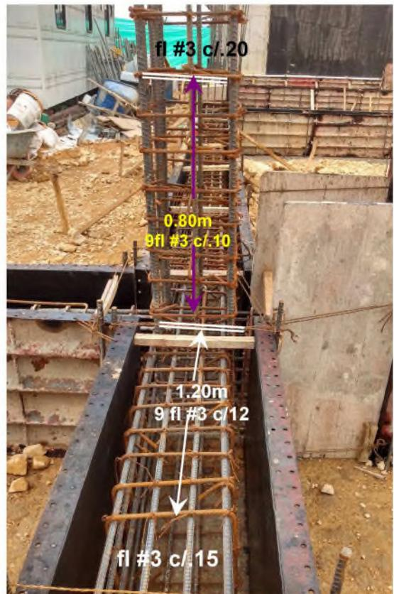
§ Se trata de una situación particular de un nudo estructural. Cuando se llama "irregularidad", no equivale a decir "error", sino que es una condición no regular, SI PERMITIDA por la norma NSR-10, pero que debe diseñarse para tal fin, como lo define C.7.9 — Conexiones y C.21.7 — Nudos en pórticos especiales resistentes a momento con capacidad especial de disipación de energía (DES) y especialmente los requisitos C.21.7.3 — Refuerzo transversal (concreto confinado)
