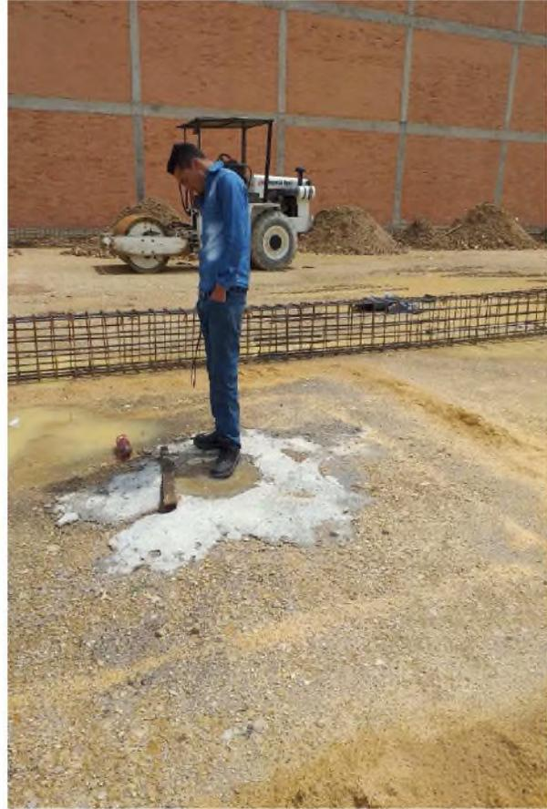
En las fotos se puede apreciar la muy buena calidad, del material granular usado en los rellenos, que corresponde a recebo B-400
