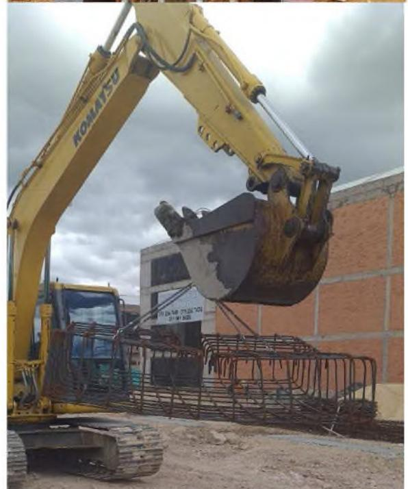
En las fotos se muestra la calidad del acero y como se ha dicho en el informe, la oxidación se concentra en los dobleces de las varillas y se trata de una oxidación leve, producida básicamente por la humedad en el aire, especialmente del rocío. Y e se debe manejar como un asunto de limpieza del acero dentro de los protocolos normales de construcción y no como un asunto de corrosión severa ni da para tema estructural.
