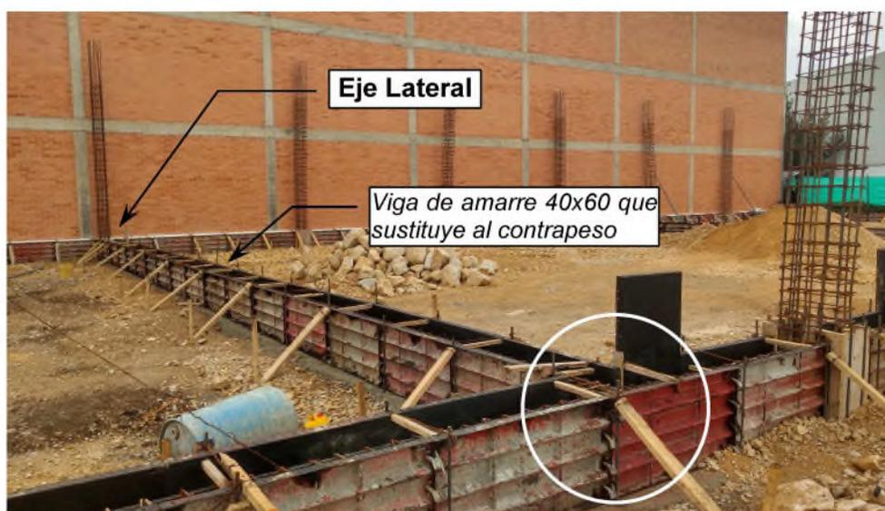
Foto: Nodo viga – viga a nivel de cimentación.
