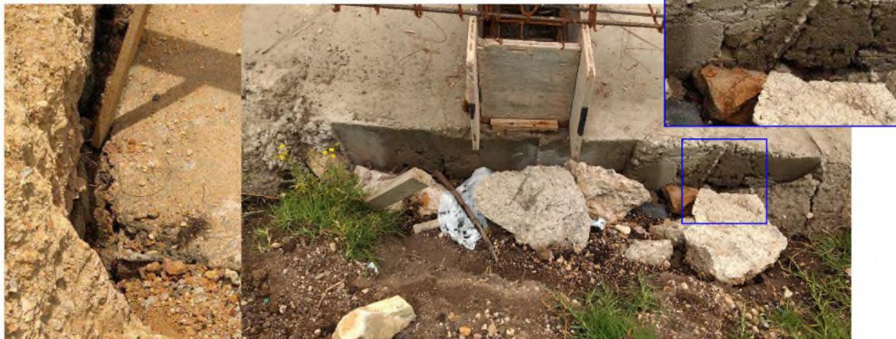
En una de las zapatas del eje de lindero del costado norte, se observa “hormigueros” y exposición del acero de refuerzo, probablemente movimientos en la formaleta y/o mal vibrado durante la fundida de la zapata. Dicha falla no compromete de manera directa la resistencia estructural del elemento, pero si la durabilidad de acero, como se analizará mas adelante y se debe hacer su reparación inmediata, bajo autorización y aprobación por parte del interventor – revisor.
