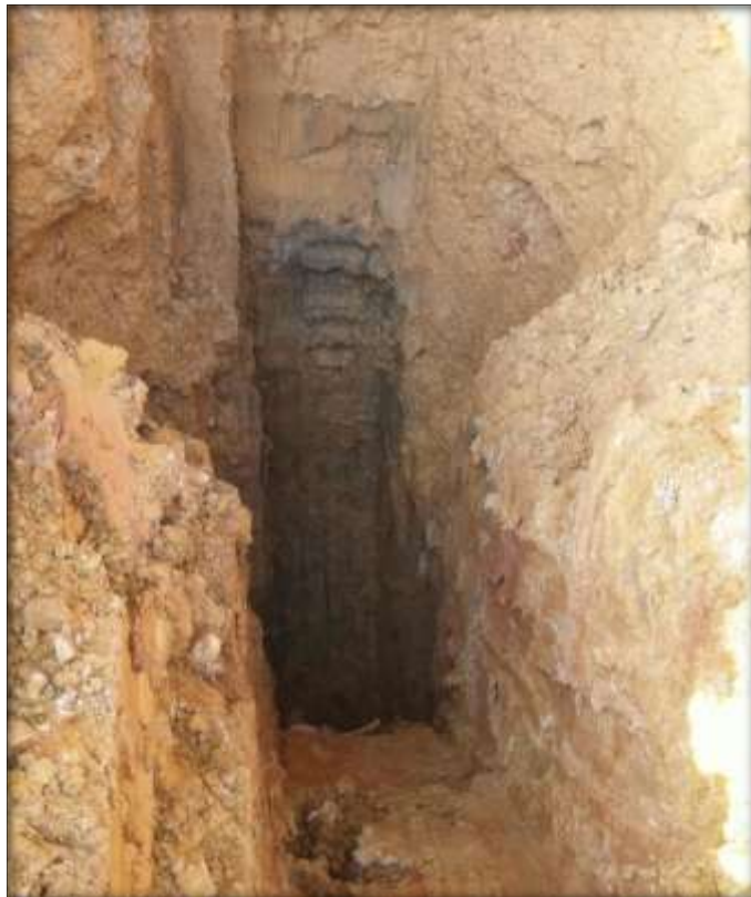
Imagen 3.1. Apique para manto 10 realizado con retroexcavadora.
