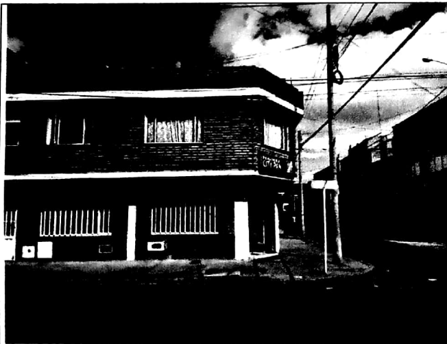
Foto No. 3 Vista general de la fachada
