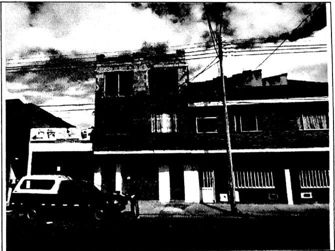
Foto No. 4 Vista general de la fachada
