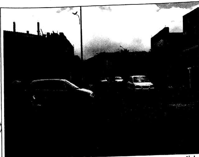
Foto No. 1 Vista de la vía de acceso en sentido Oeste - Este
