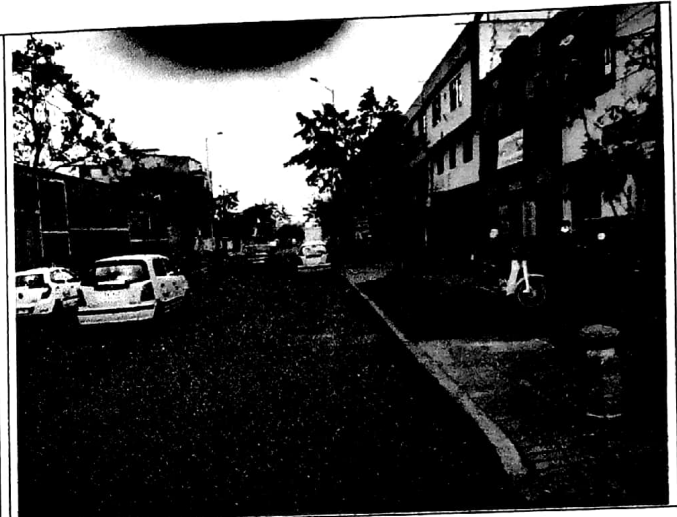
Foto No. 2 Vista de la vía de acceso en sentido Este - Oeste
