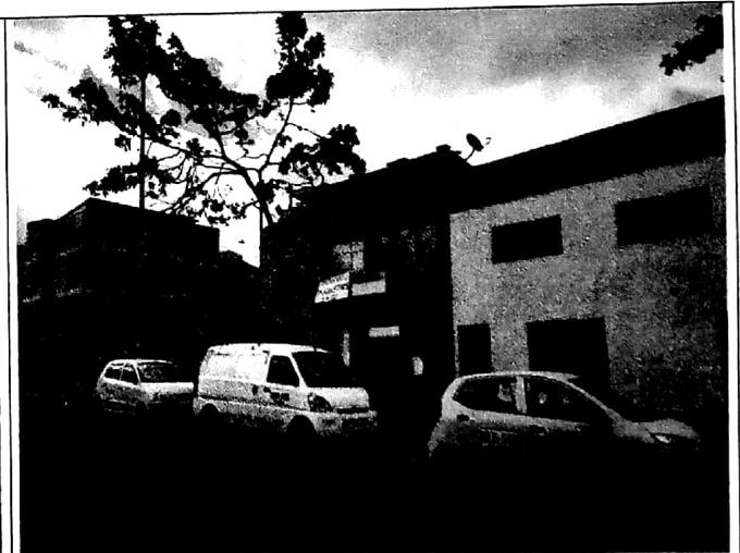
Foto No. 4 Vista general de la fachada
