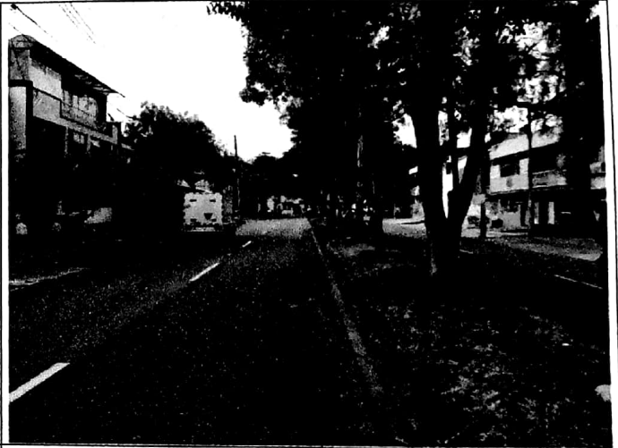
Foto No. 2 Vista de la vía de acceso en sentido Este - Oeste
