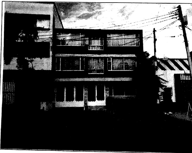
Foto No. 3 Vista general de la fachada
