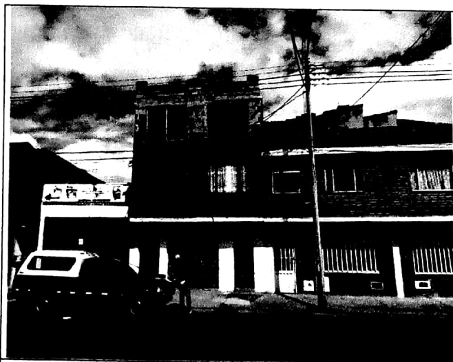
Foto No. 3 Vista general de la fachada
