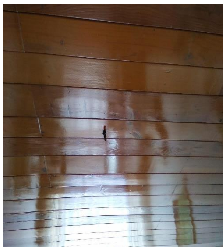
Enchape en techos.
