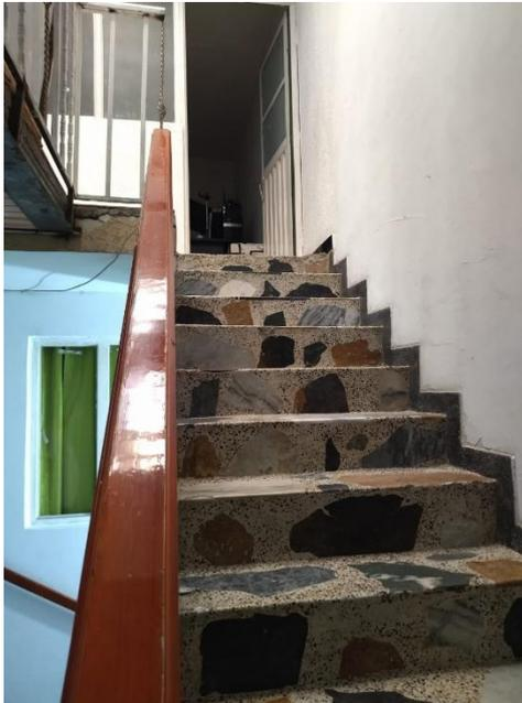
Escaleras en retal de mármol con baranda en madera soportada en hierro que nos conduce al tercer nivel paredes pañetadas estucadas y pintadas en buen estado de conservación.
