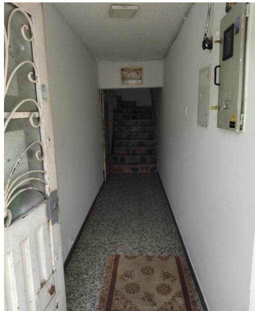
Puerta metálica de una hoja, piso es en baldosín mármol, paredes pañetadas, estucadas y pintadas, techo en carraplast. Seguidamente encontramos una reja metálica la cual nos da acceso a un hall donde se aprecia escaleras que nos conduce al segundo nivel en retal de mármol.
