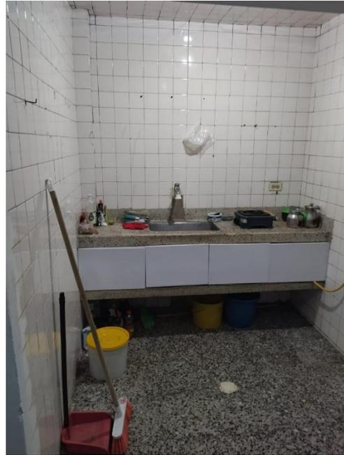
Paredes y techo enchapados en azulejos con mesón en autoconstrucción en granito pulido con poseta para lavaplatos, pisos en baldosín.
