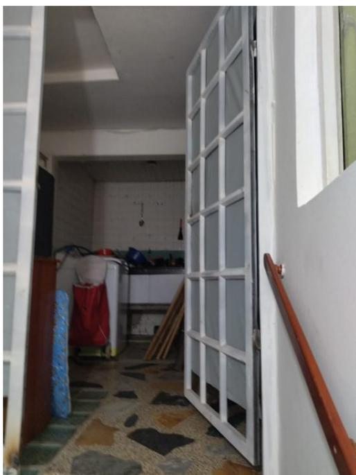
Hall de distribución con puerta de ingreso en reja metálica, paredes pañetadas estucadas y pintadas pisos son en retal de mármol, techo en carraplast en regular estado de conservación. Este nos da acceso a una cocina, baño y 4 alcobas.
