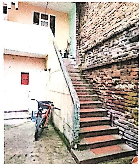
2 NIVEL PARTE POSTERIOR ESCALERAS AL SEGUNDO NIVEL
