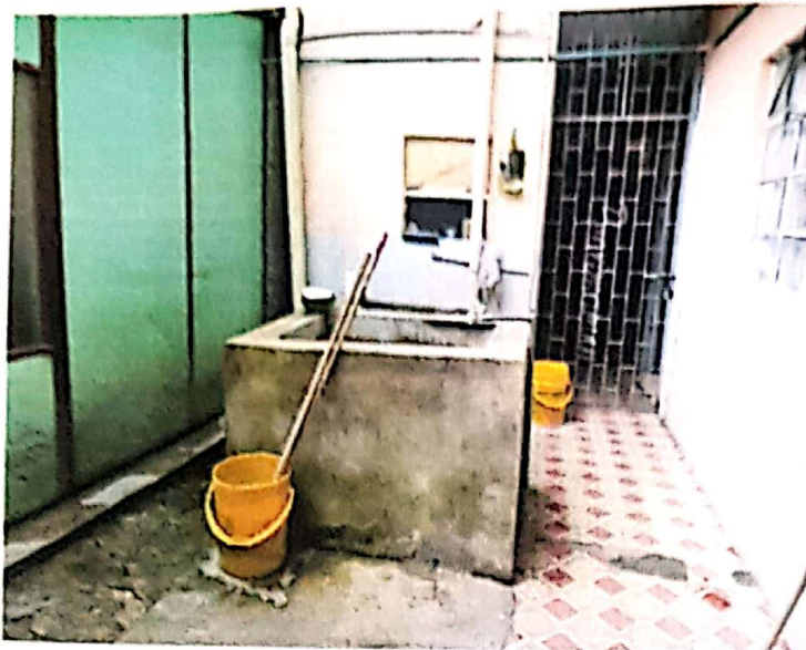
AREA DE LAVADO Y COCINA AL FONDO
