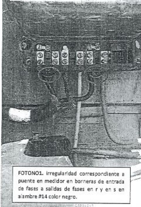
FOTONO1. Irregularidad correspondiente a puente en medidor en borneras de entrada de fases a salidas de fases en r y en s en alambre #14 color negro.
