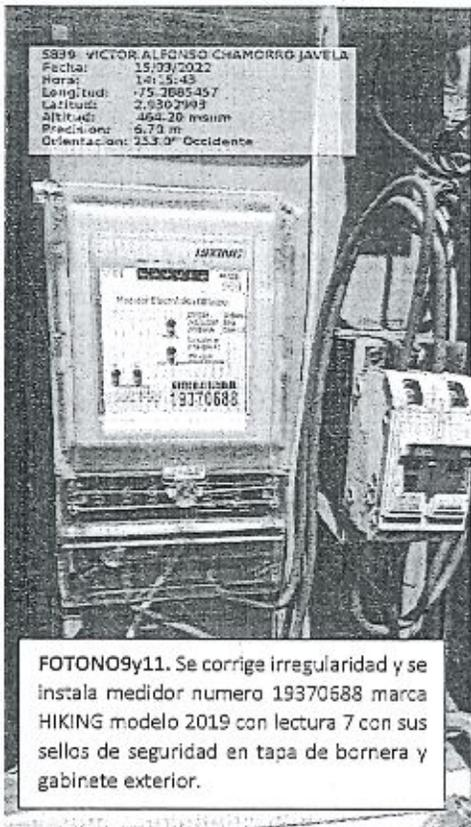
FOTONO9y11. Se corrige irregularidad y se instala medidor numero 19370688 marca HIKING modelo 2019 con lectura 7 con sus sellos de seguridad en tapa de bornera y gabinete exterior.
