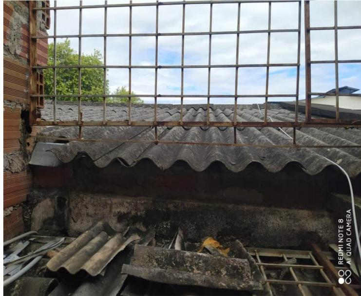
**IMAGEN 12. Se aprecia cubierta en machimbre y su estado de conservación**
