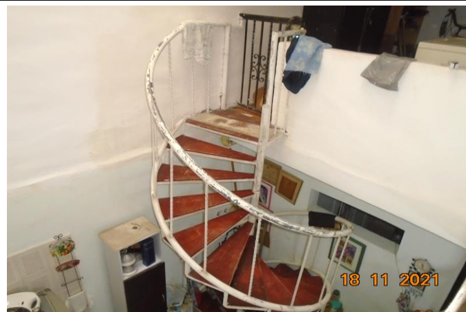
Escaleras internas a segundo piso
