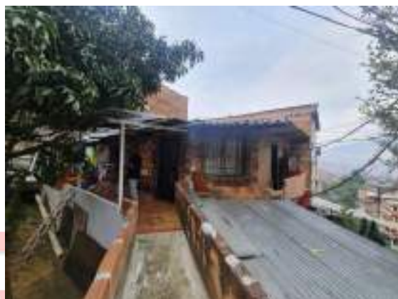
ACCESO SEGUNDO PISO
