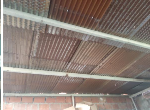
Techo de cobertizo
