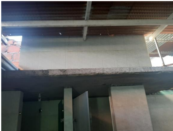
Tanque elevado en ladrillo 1,2 M3
