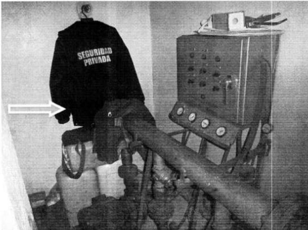
Aquí se observa el cuarto del sistema de comando hidroneumático, al igual que la zona del hidroflo área vital del conjunto debe permanecer despejado de cualquier elemento
