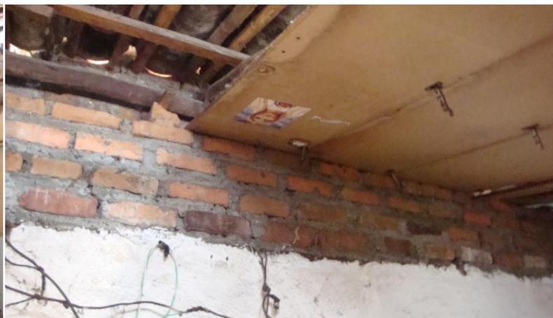
CUBIERTA Y CIELO FALSO EN MAL ESTADO
