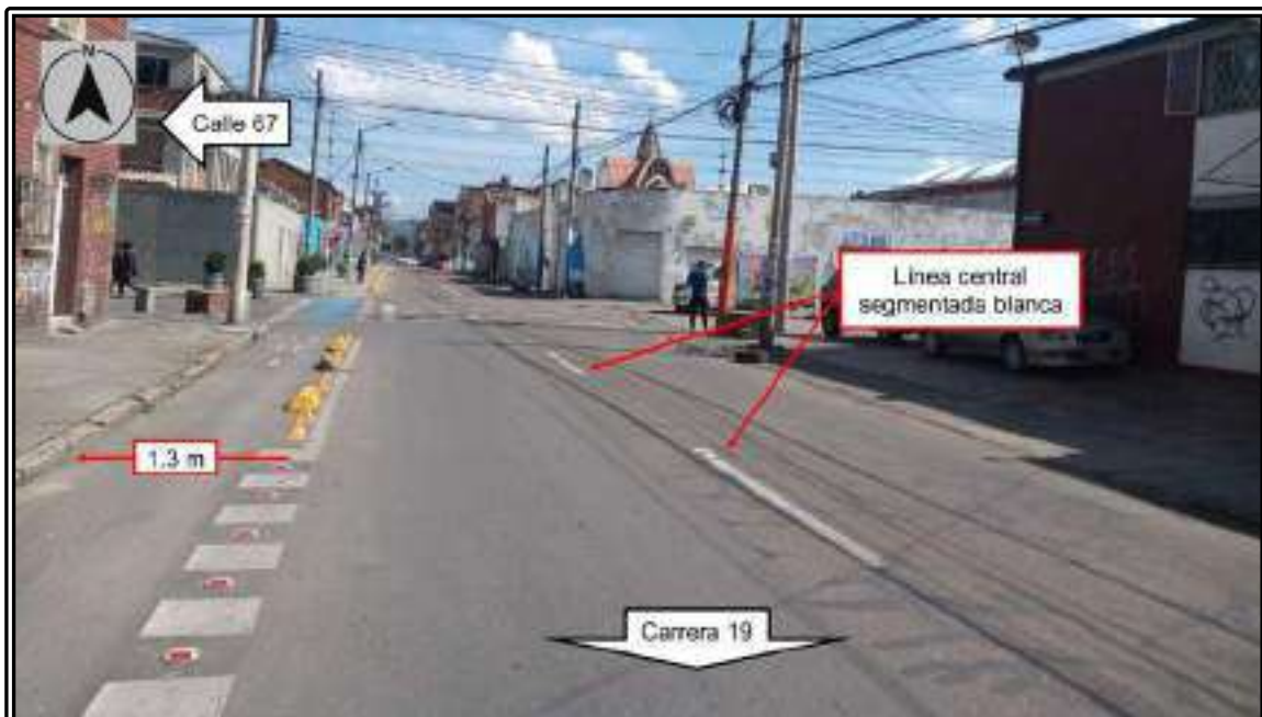
Imagen 2.5 Características de la vía
