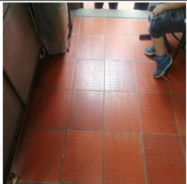
Piso Cuarto de Ropas
