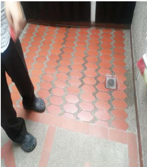
Piso Patio Interno 2
