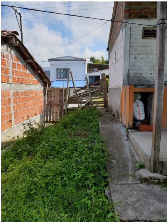
Imagen 1: Entrada lateral de la vivienda. Se observa mortero, columnas y vigas en concreto, cerco de guadua.
