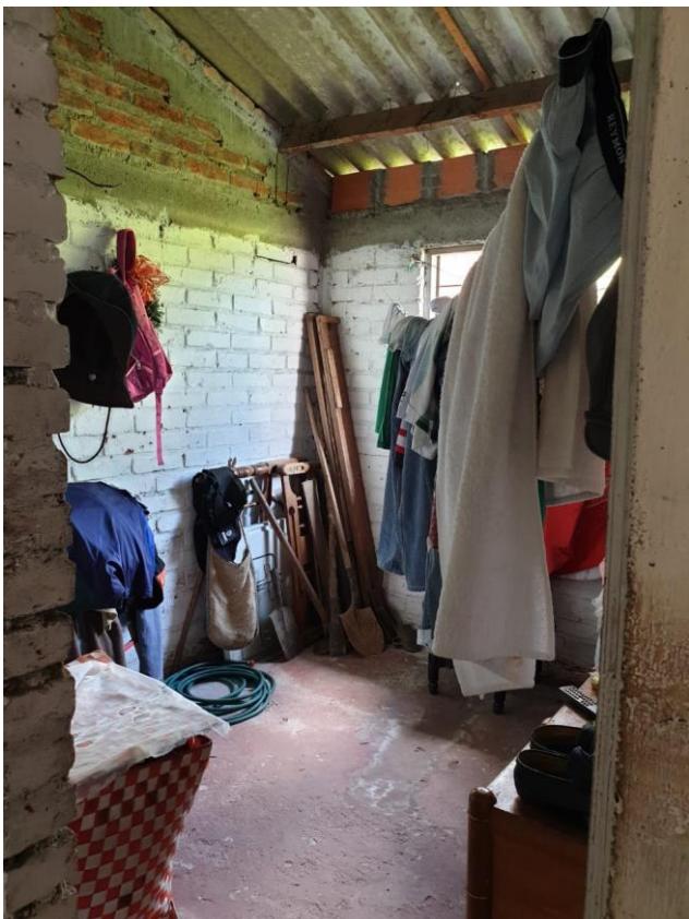
Imagen 15: Habitación 2 con tendero de ropa y herramientas. Se observan vigas y columnas en concreto. El piso está mejorado con anilina mineral, material usado para embellecer las casas rurales.
