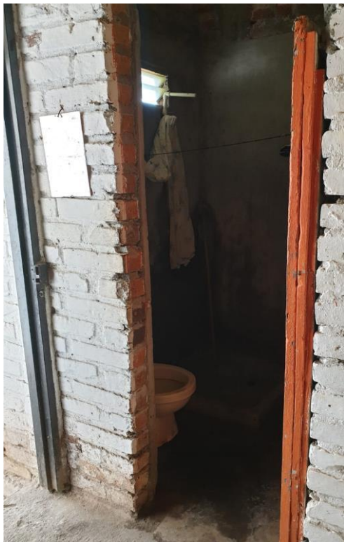
Imagen 5: Entrada Baño con puerta de metal.
