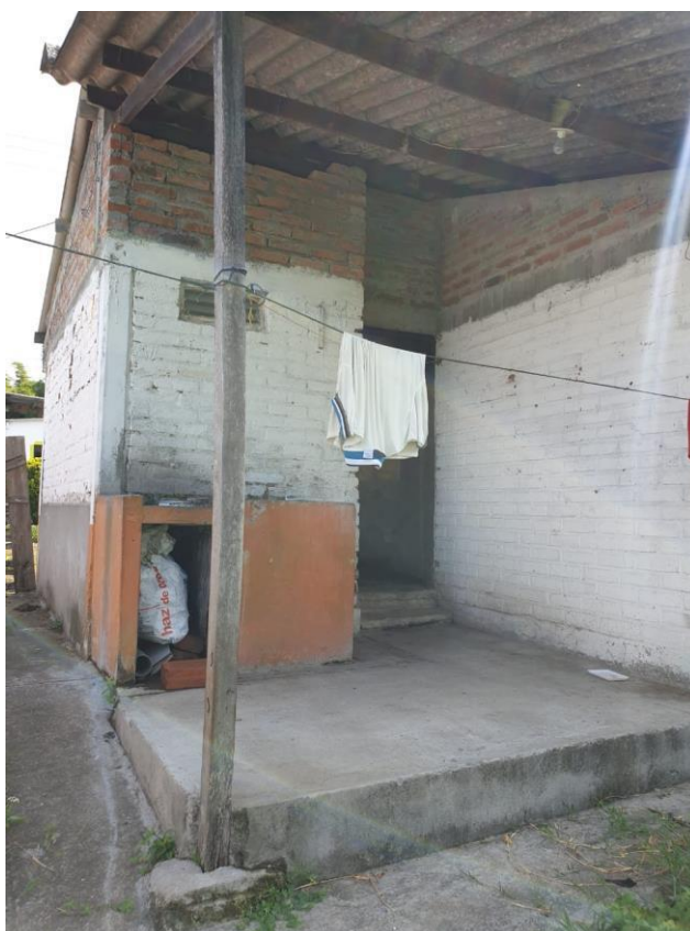
Imagen 18: Salida a parte trasera. Se puede observar un buen mortero en concreto, un lavadero funcional, columna de madera gruesa, techo de Eternit, paredes en ladrillo pintadas de blanco.
