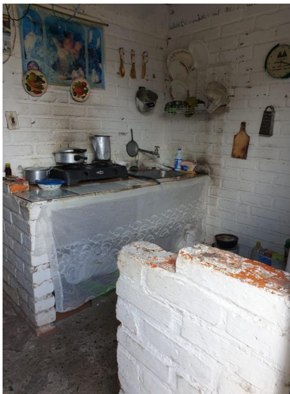
Imagen 2: Cocina. Se observa una cocina funcional en ladrillo y cemento, con platero y entrepaños para acomodar las ollas.
