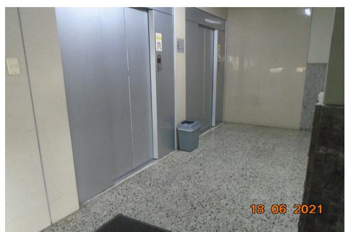
Acceso ascensores piso 8
