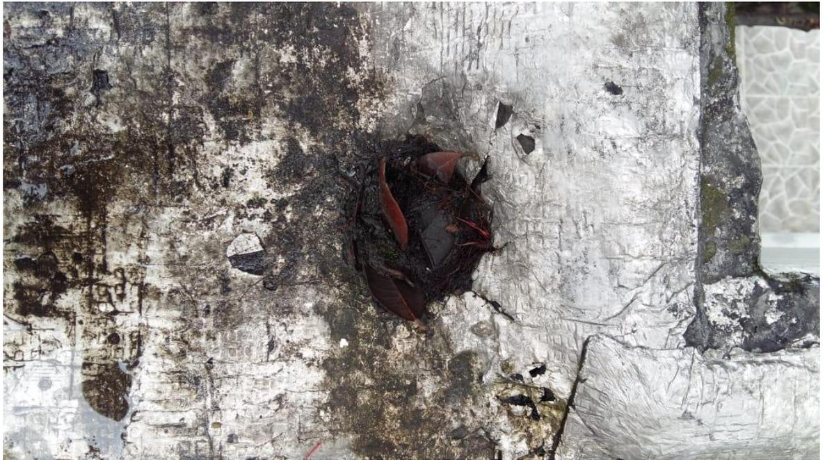
**Daño en techos, humedad. Material en deterioro (no fue atendido) 2019**
