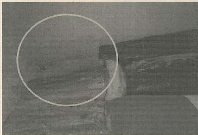
Humedad en la losa de concreto de la alcoba #1
