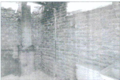
DETALLE AVANCE DE OBRA PISO 03
