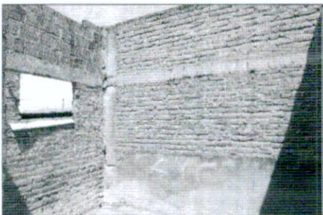
DETALLE AVANCE DE OBRA PISO 03
