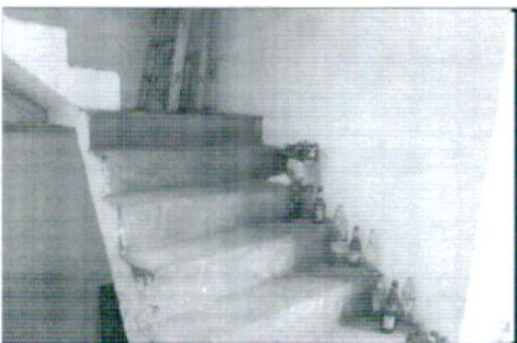
ACCESO INTERNO PISO 03
