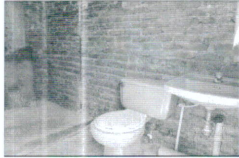
DETALLE AVANCE DE OBRA PISO 03
