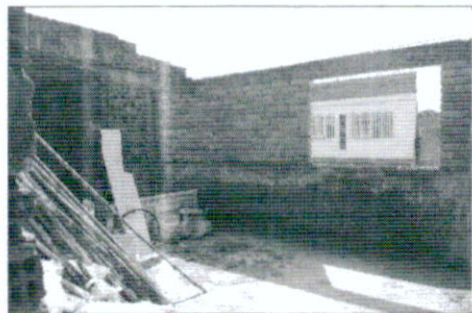
DETALLE AVANCE DE OBRA PISO 03
