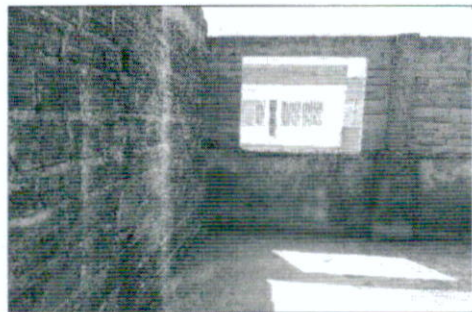
DETALLE AVANCE DE OBRA PISO 03
