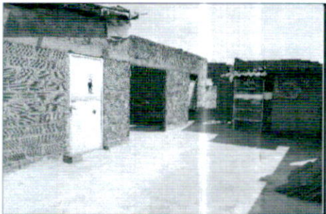
DETALLE AVANCE DE OBRA PISO 03
