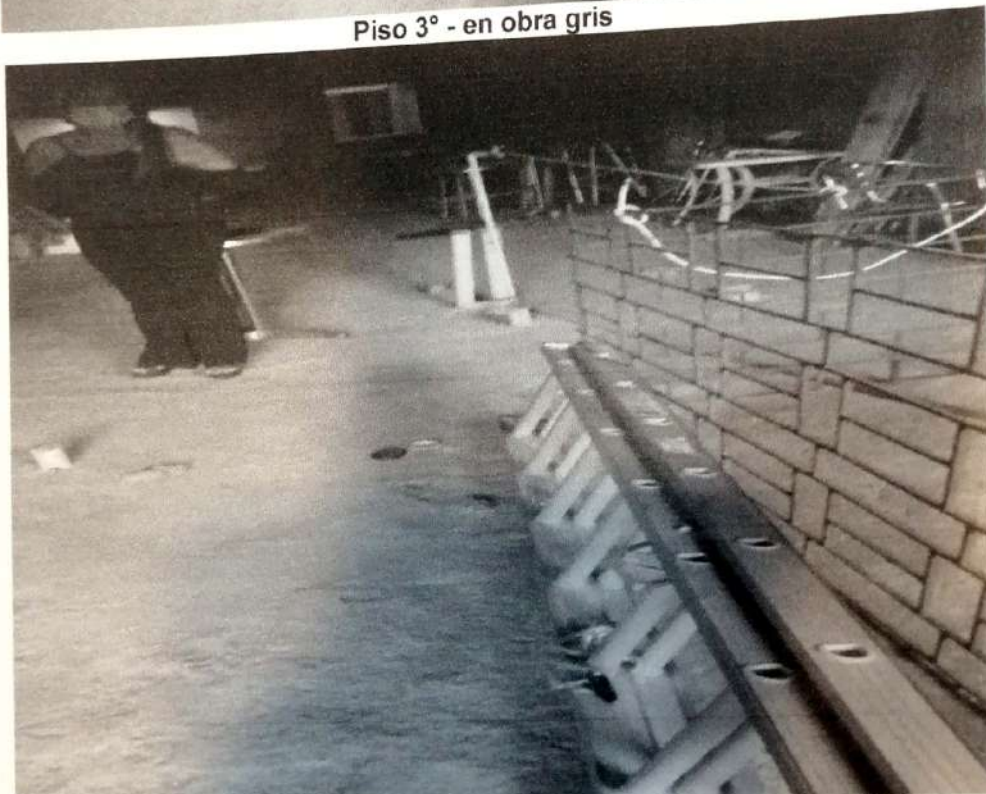
Piso 3° - en obra gris – pisos sin enchape y solo muros periféricos sin acabado
