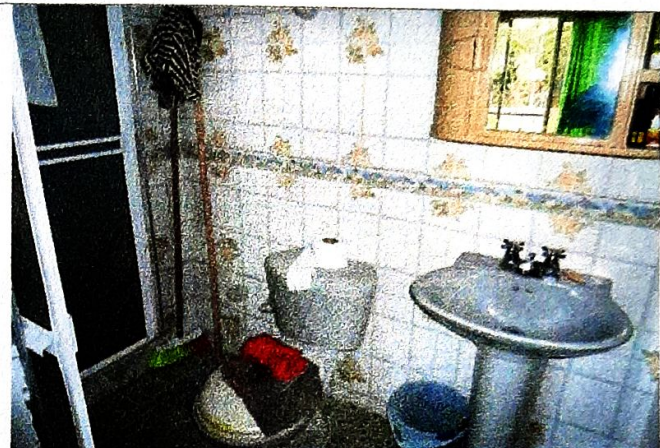
INTERIOR SEGUNDO PISO
