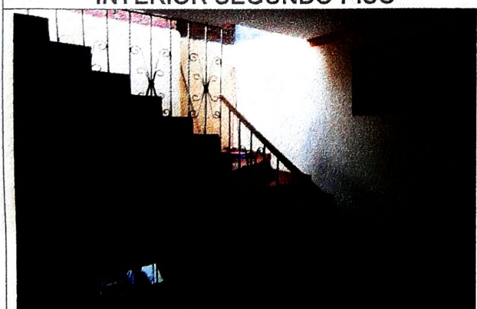
ESCALERAS ACCESO TERRAZA
