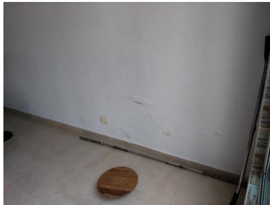
Imagen 30. Humedad presente al interior del Gimnasio
