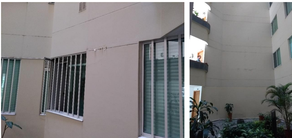
Imagen 35 y 36. Estado actual fachada interna
