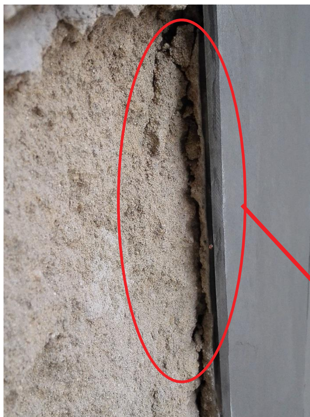
Imagen 9. Detalle de las losas desprendidas
