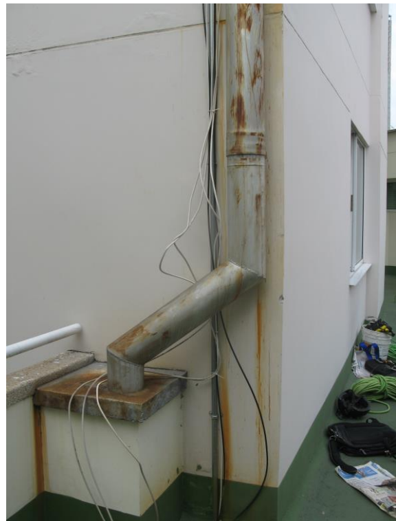
Oxidación del ducto de la planta eléctrica.
