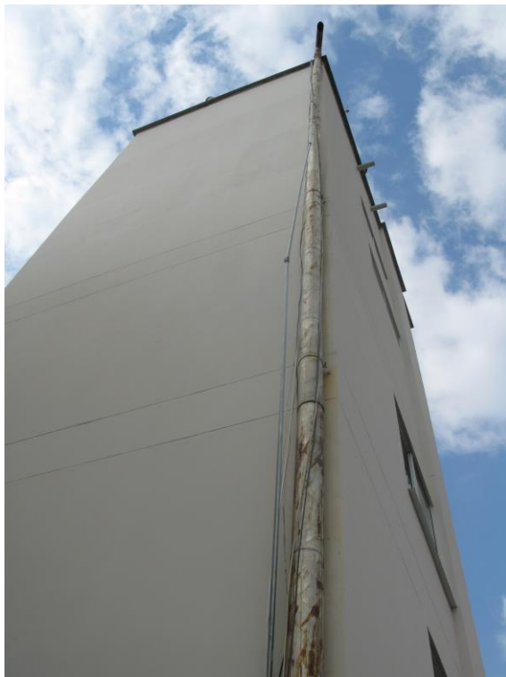
Oxidación del ducto de la planta eléctrica.
