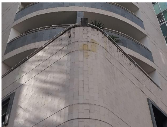
Imagen 2. Estado actual fachada
