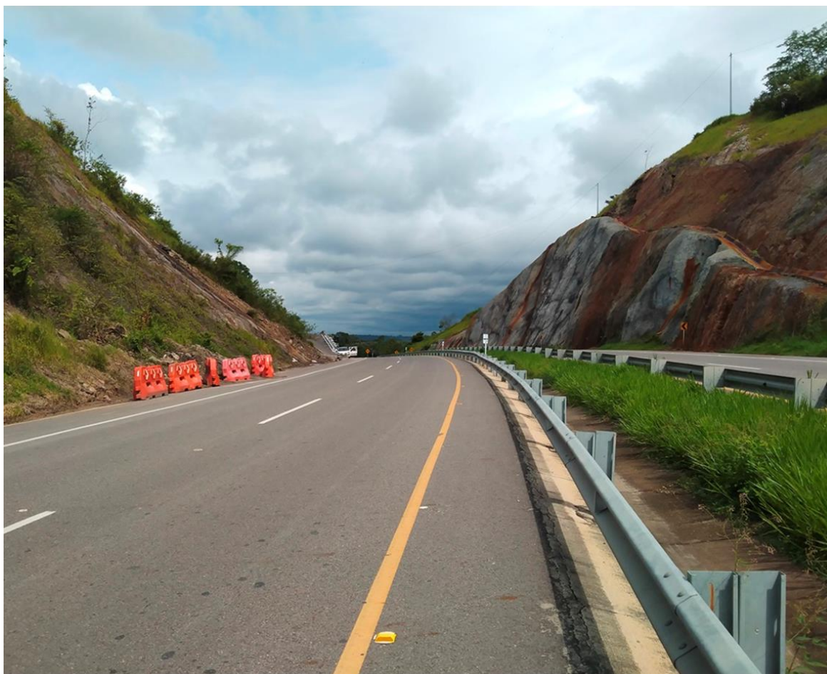
Fotografía No.5 Panorámica : Se observa el estado actual del sector donde ocurrieron los hechos.
