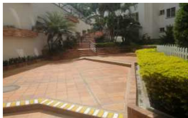
Zonas de circulación peatonal
