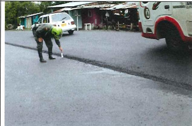
**IMAGEN 43. TOMA 94.** Diferencia de nivel entre la capa de pavimento antigua y la nueva.
